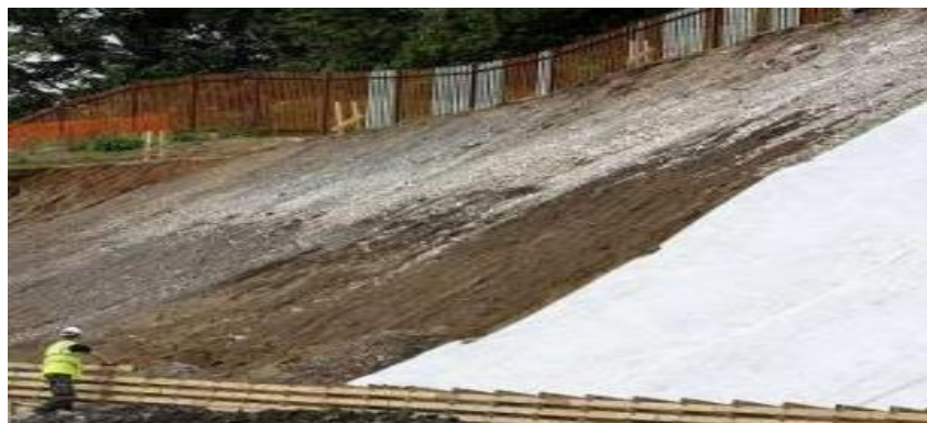
Figura 15: Proteção do talude com geotêxtil
