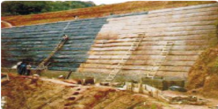
Figura 18: Vista frontal do muro reforçado
