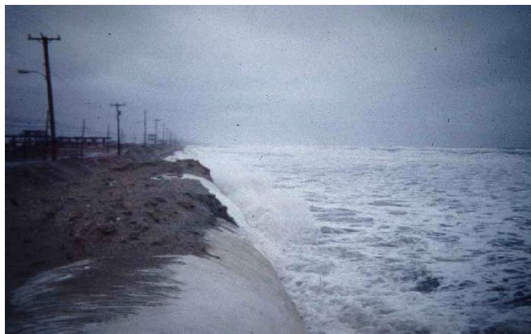
Figura 29: Tubo geotêxtil durante tempestade
