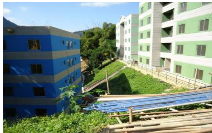
Figura 24: Três meses após a colocação da geomanta reforçada - Obra de Angra dos Reis- RJ
