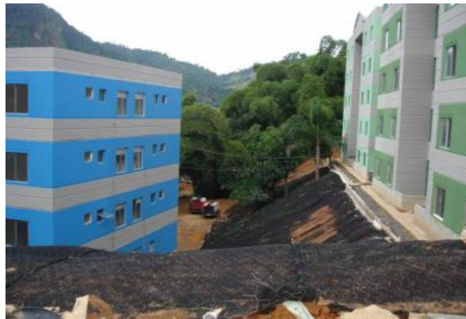
Figura 23: Talude com a geomanta reforçada - Obra de Angra dos Reis - RJ
