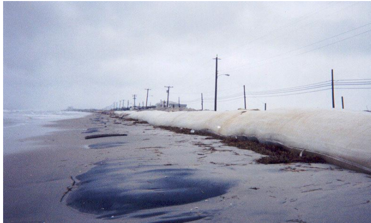
Figura 30: Tubo de geotêxtil após a tempestade
