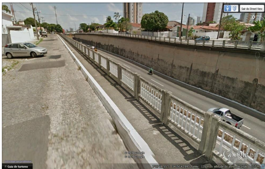
Figura 4 - Passagem inferior utilizada para o escoamento de via expressa
