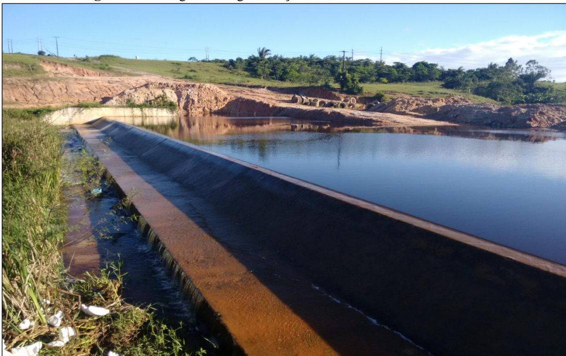
Figura 4 - Barragem de regularização de nível no rio Tibiri
