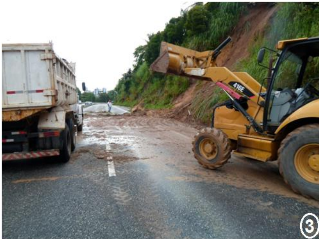
FIGURA 25: Deslizamento na Comunidade Santa Clara que invadiu a Br 230 no Km 19
