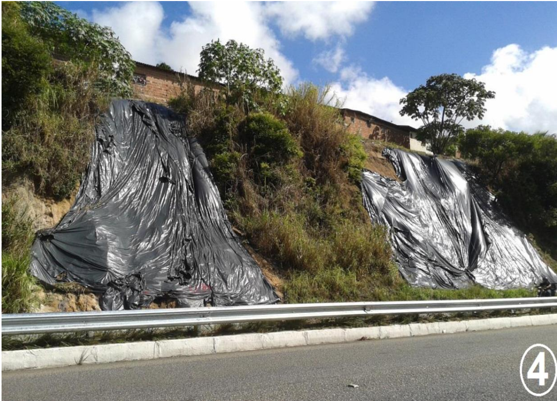
FIGURA 26: Lonas protegendo o talude
