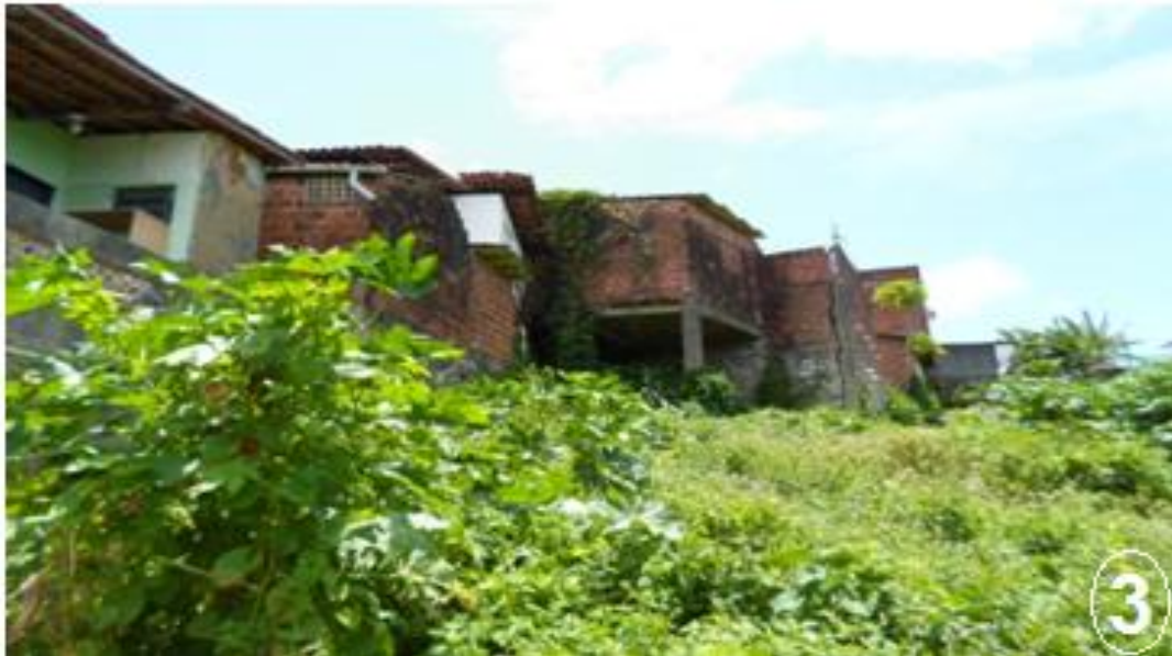
FIGURA 18: Casas construídas no topo do talude
