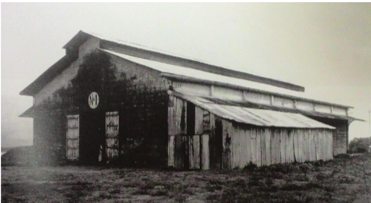
Figura 7: Primeiro armazém do Porto de Cabedelo (1917)
