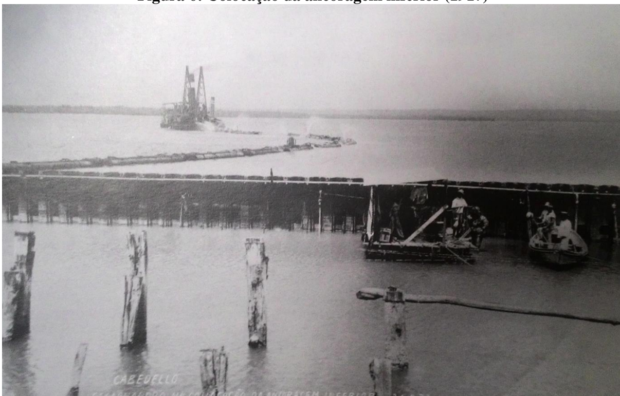
Figura 6: Colocação da ancoragem inferior (1917)
