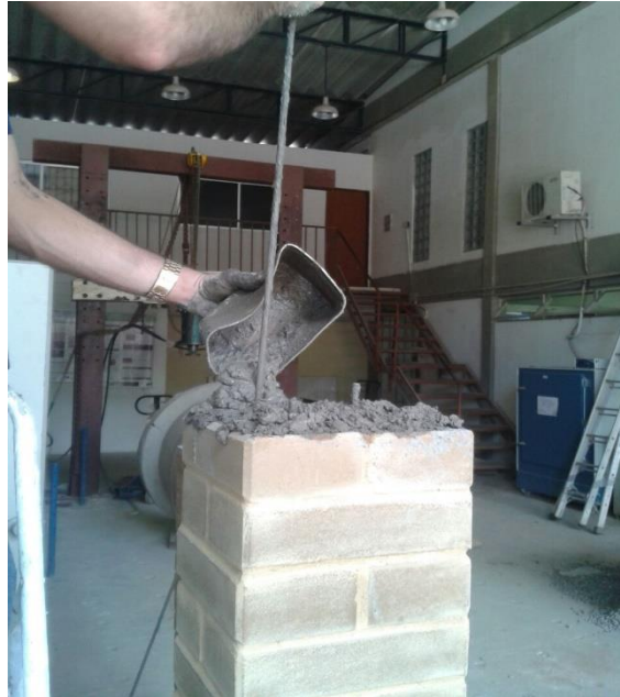
Figura 21 - Lançamento do Graute
