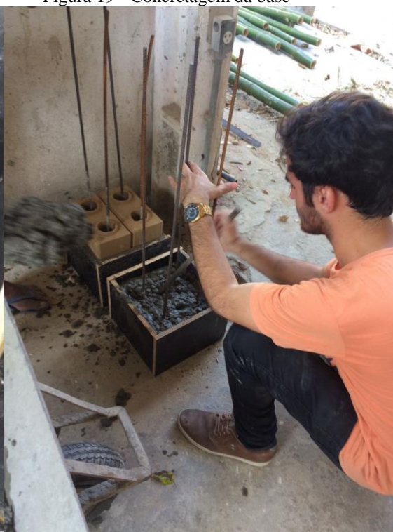
Figura 19 - Concretagem da base
