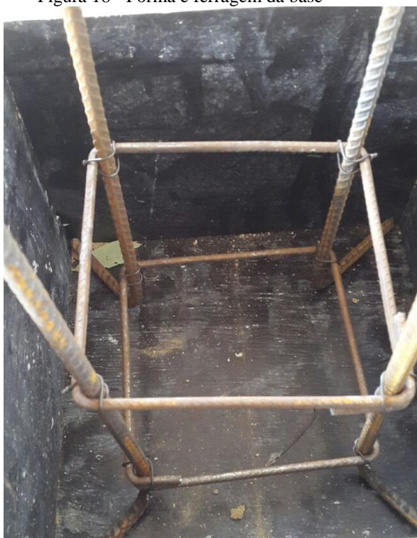
Figura 18 - Forma e ferragem da base
