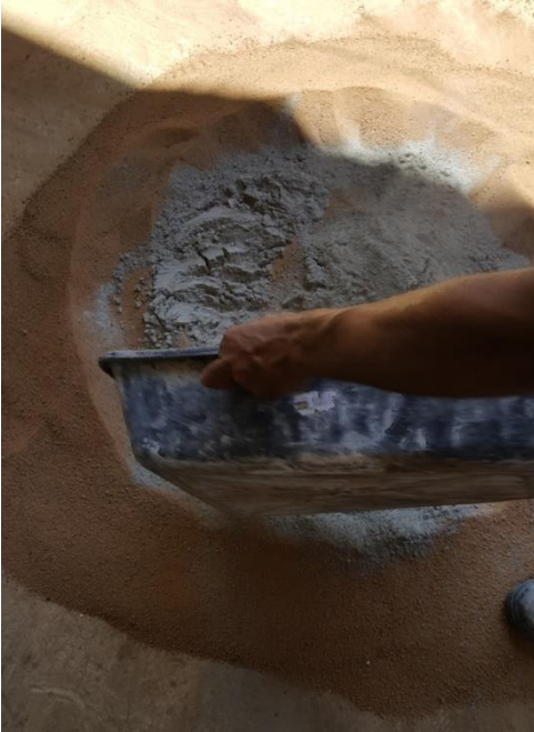
Figura 14 - Mistura do solo com o cimento
