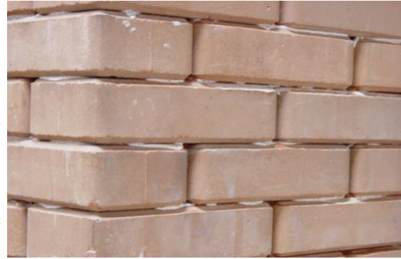
Figura 6 - Blocos assentados com cola de PVA
