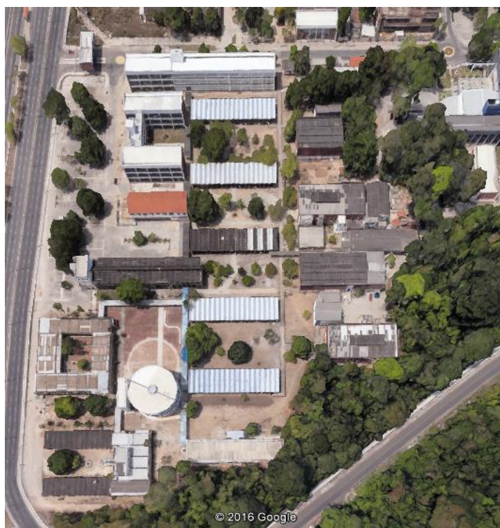
Figura 4- Centro de Tecnologia da UFPB. Fonte: Google Earth
