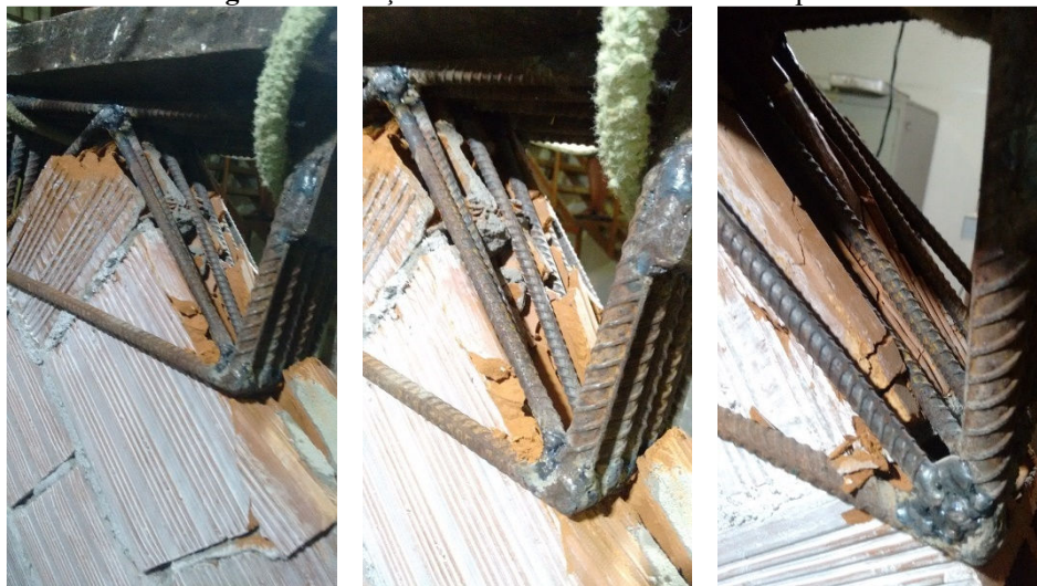
Figura 33: Punção dos blocos em contato com o apoio.
