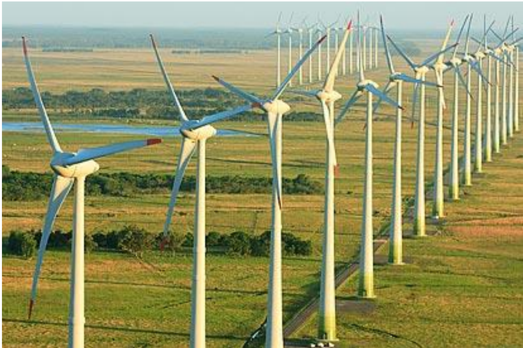
Figura 1 – Parque Eólico Osório no Brasil ( Onshore )
