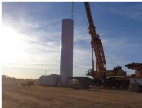
A - Montagem do primeiro seguimento da torre.
