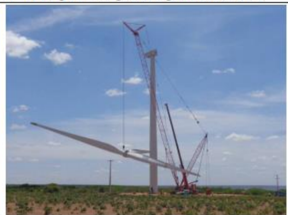
D - Montagem das pás.
