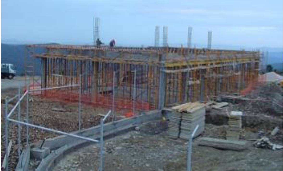
Figura 10 – Edifício de Comando
