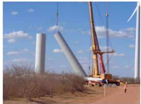
B - Montagem do segundo seguimento da torre.
