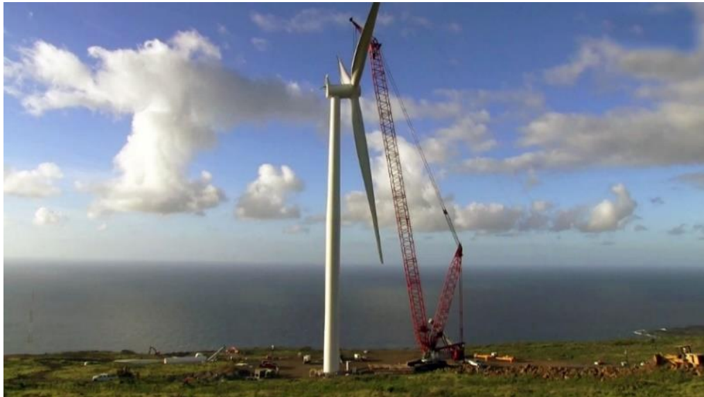
Figura 7 – Plataforma de montagem
