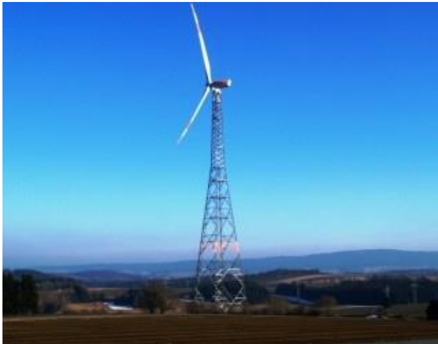
Figura 16 – Torre eólica treliçada
