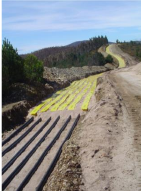
Figura 9 – Colocação de cabos de Média Tensão em vala
