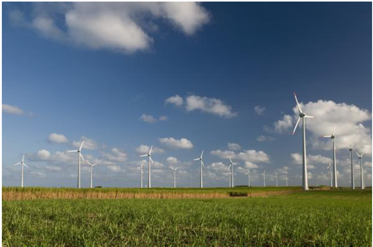
Figura 24 – Parque Eólico Vale dos Ventos, situado na cidade de Mataraca-PB
