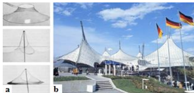
Figura 1 - Modelos Indiretos de Frei Otto – a) Modelos em bolhas de sabão; b) Pavilhão Alemão.
