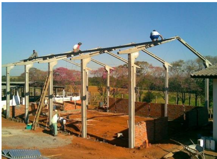
Figura 36 – Galpão de Concreto Pré-Moldado - Maringá, PR.
