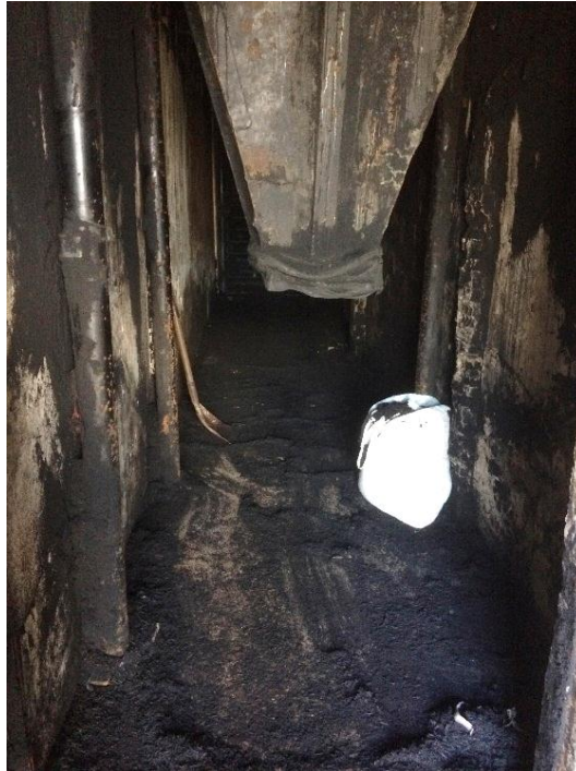
Figura 7 – Depósito de armazenamento de borracha moída
