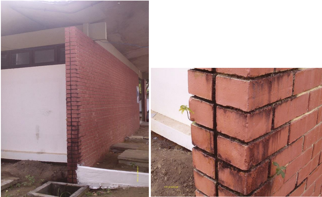
Figuras 45 e 46 - Manchas causadas por causa de micro-organismos.
