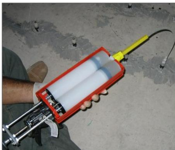
Figura 33 – Injeção de resina epoxídica em fissuras.
