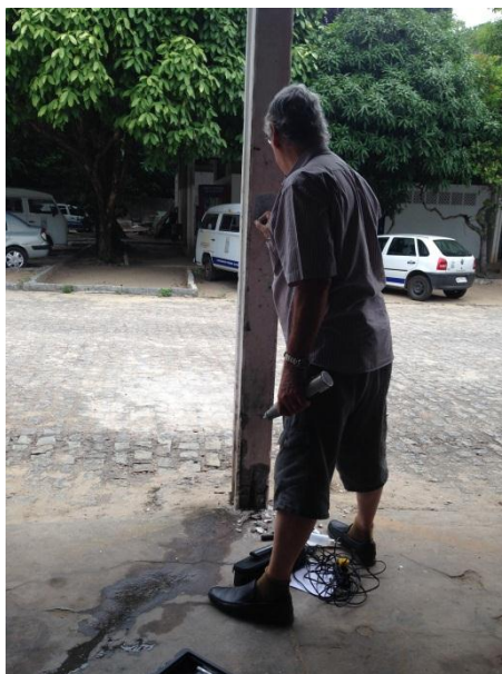
Figura 45 – Execução de marcação para o ensaio de esclerometria.
