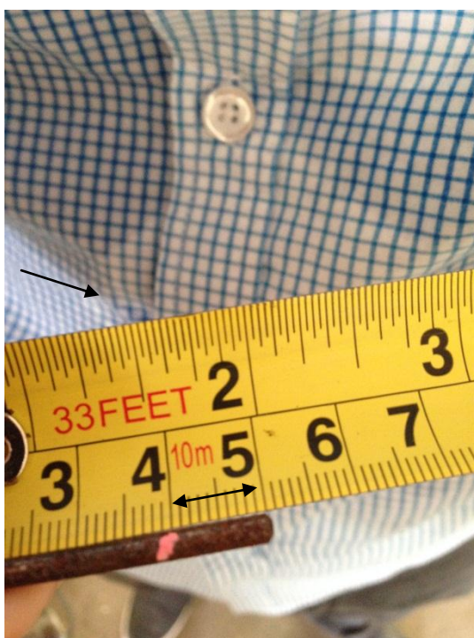
Figura 48 – Medição da profundidade de carbonatação.
