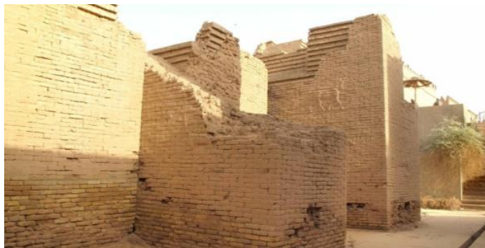
Figura 1 – Ruínas babilônicas no Iraque, construídos com tijolos de barro maciços.
