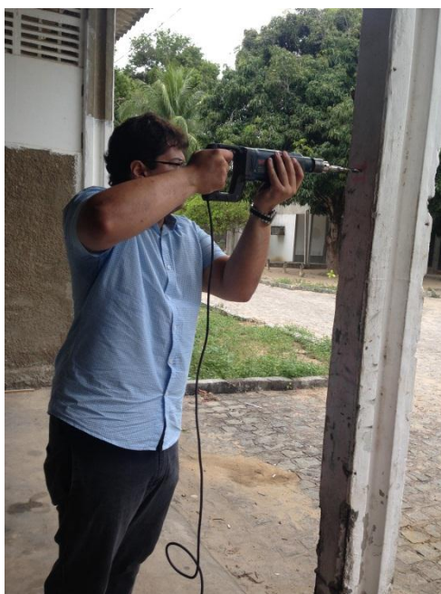
Figura 46 – Execução de furo em pilar para ensaio de profundidade de carbonatação.
