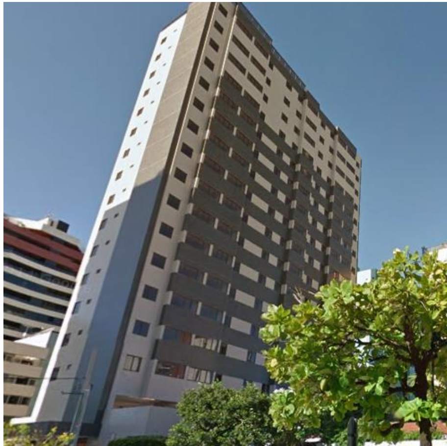
Figura 6: Edificação localizada na R. Monteiro Lobato – Tambaú, João Pessoa PB.
