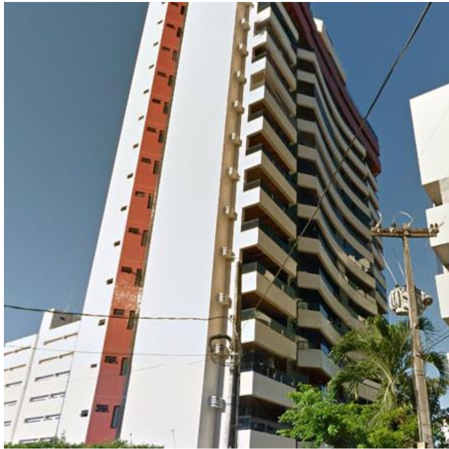
Figura 5: Edificação localizada na R. Monteiro Lobato – Tambaú, João Pessoa PB.
