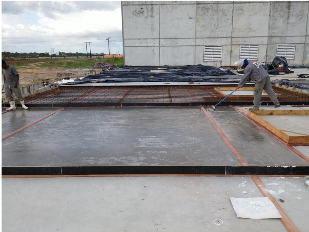
Figura 16 – Aplicação de desmoldante sobre o piso para concretagem dos painéis
