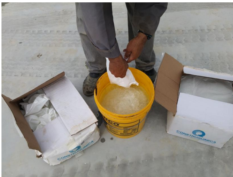
Figura 13 – Preparação da fibra de vidro a ser misturada ao concreto
