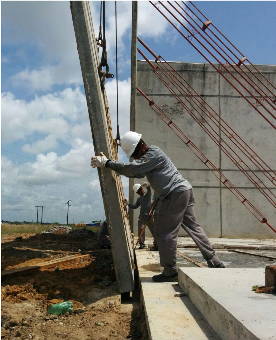
Figura 20 – Posicionamento dos painéis
