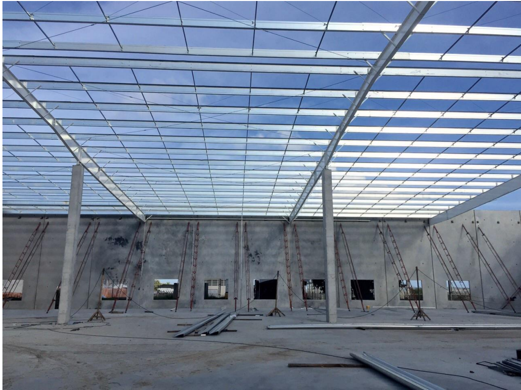
Figura 22 – Estrutura e fechamentos de coberta
