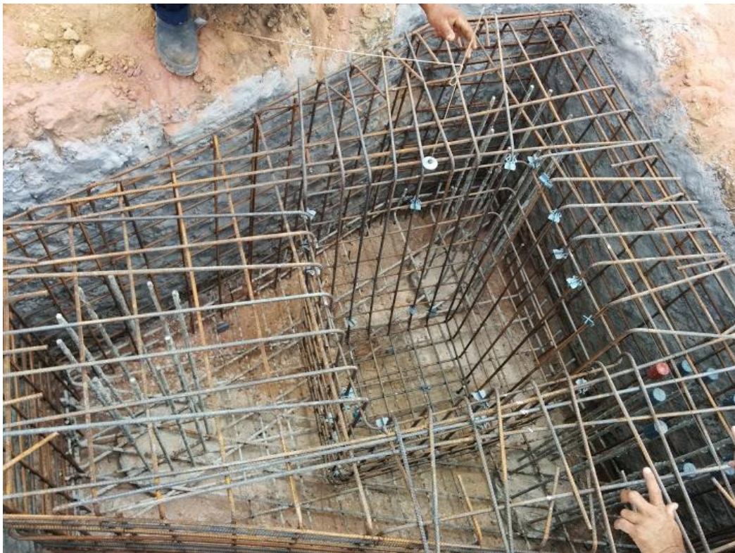
Figura 12 – Bloco de fundação
