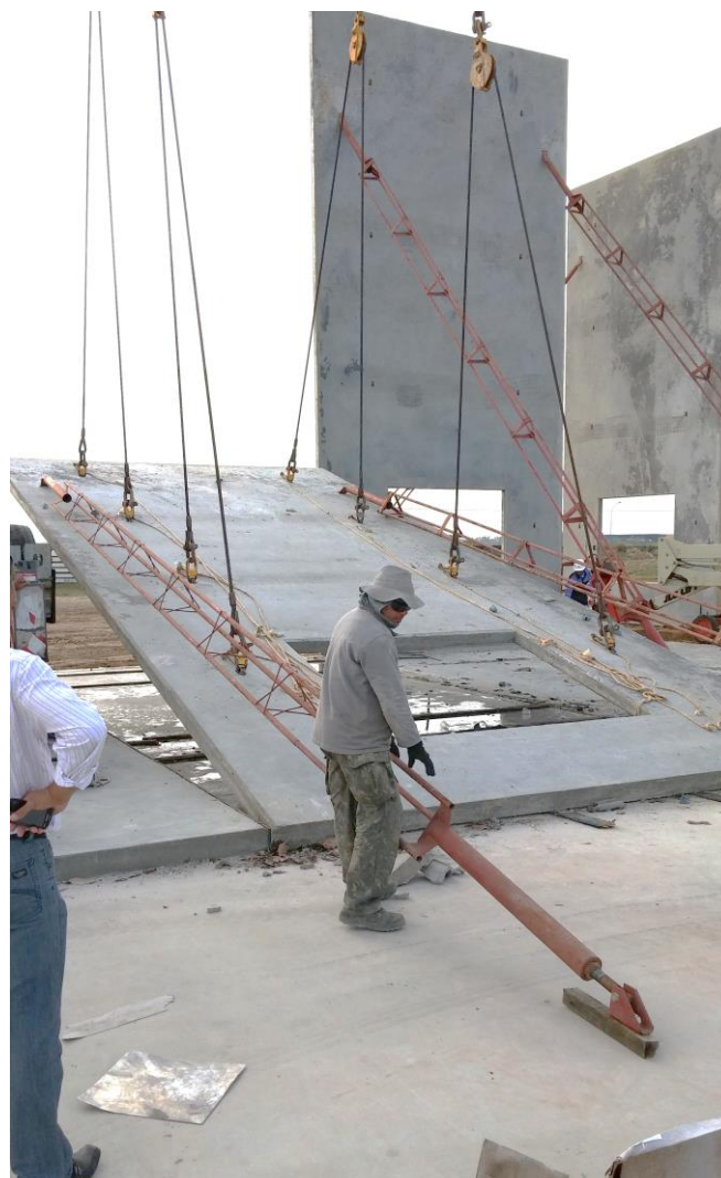
Figura 19 – Levantamento do painel tilt-up
