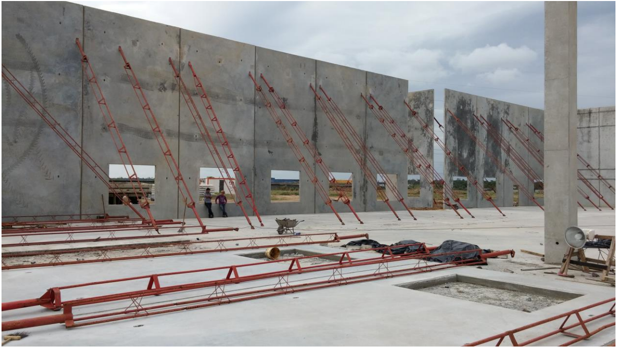
Figura 21 – Escoramento dos tilt-ups
