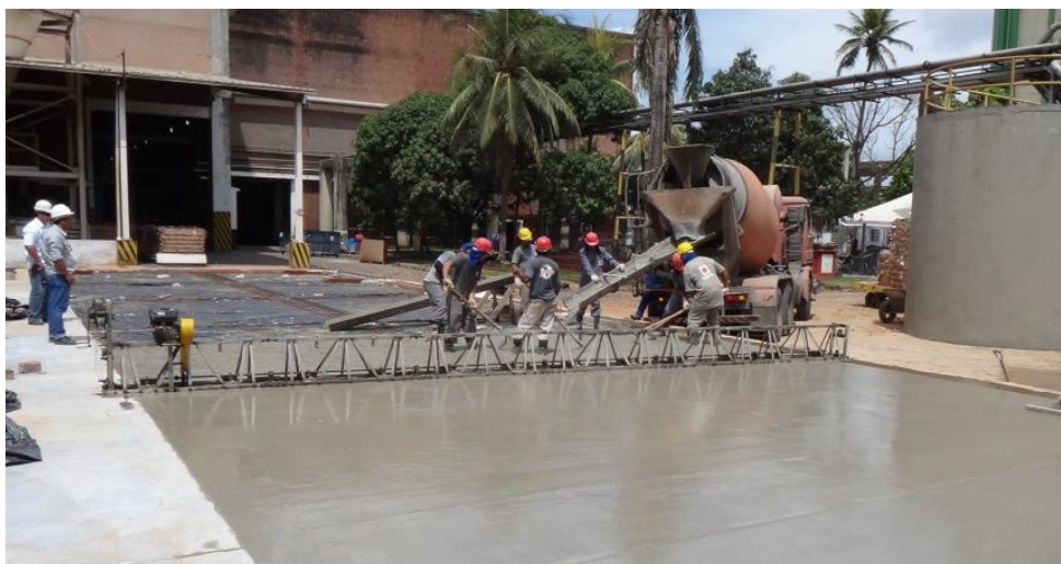
Figura 2 – Nivelamento e adensamento do concreto através de régua vibratória
