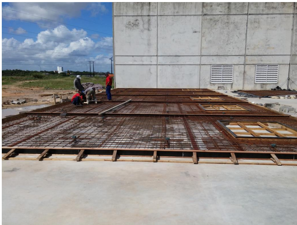
Figura 17 – Preparação das armaduras dos painéis
