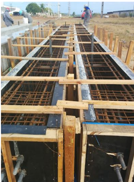
Figura 15 – Pilares prontos para serem concretados
