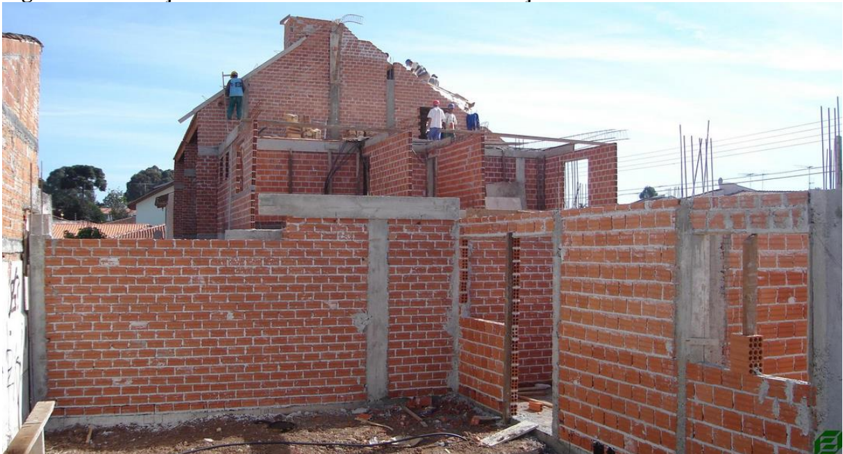
Figura 2 – Execução de uma casa em alvenaria de vedação
