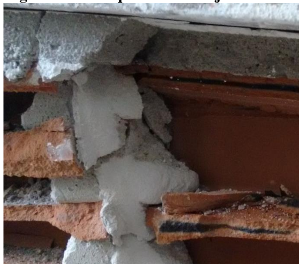
Figura 20 – Má qualidade do tijolo utilizado
