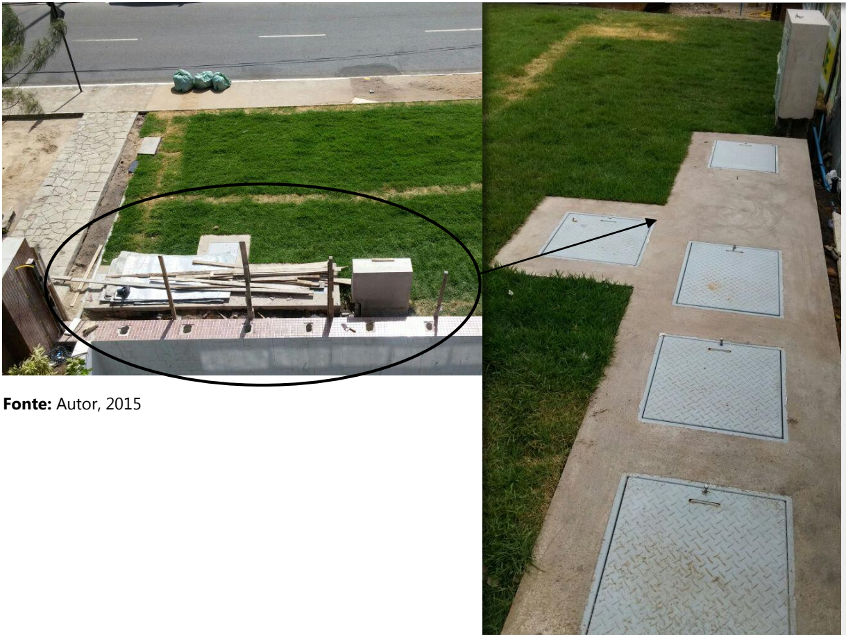
Figura 19 - Sumidouro em calçada - Bairro do Cabo Branco
