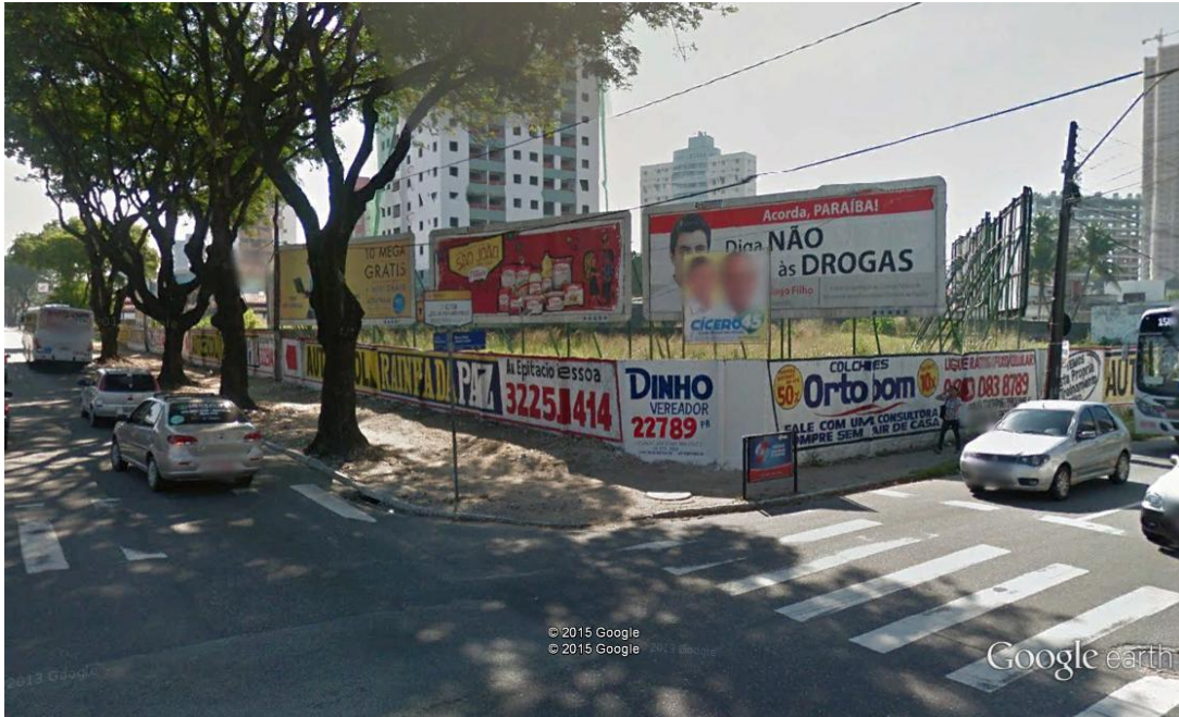
Figura 32 - Calçada não pavimentada na av. Epitácio Pessoa
