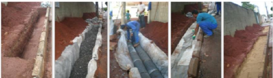
Figura 16 - Vala de infiltração
