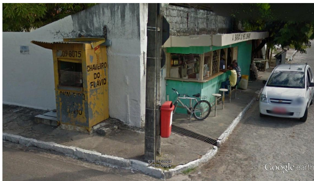
Figura 29 - Lanchonete utilizando mais de 50% da calçada na avenida Santa Catarina - Bairro dos Estados
