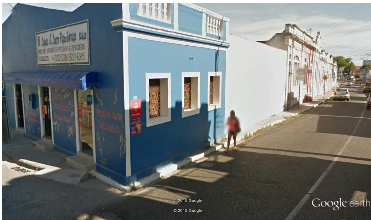
Figura 7 - Parte sem calçada - Rua das Trincheiras, Centro.
