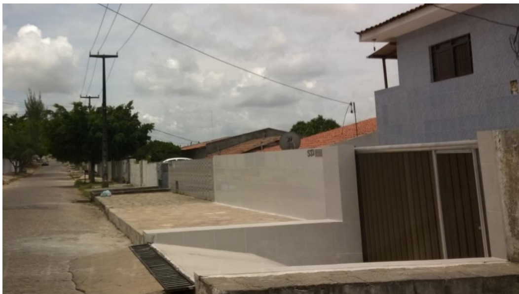
Figura 45 - Calçada com desnível - Castelo Branco
