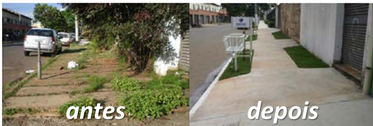
Figura 15 - Trecho de calçada restaurada
