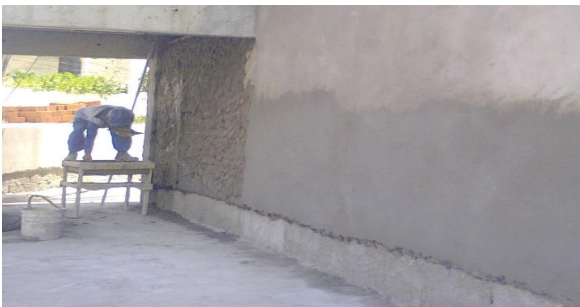
Figura 3 –Execução do reboco Tradicional
