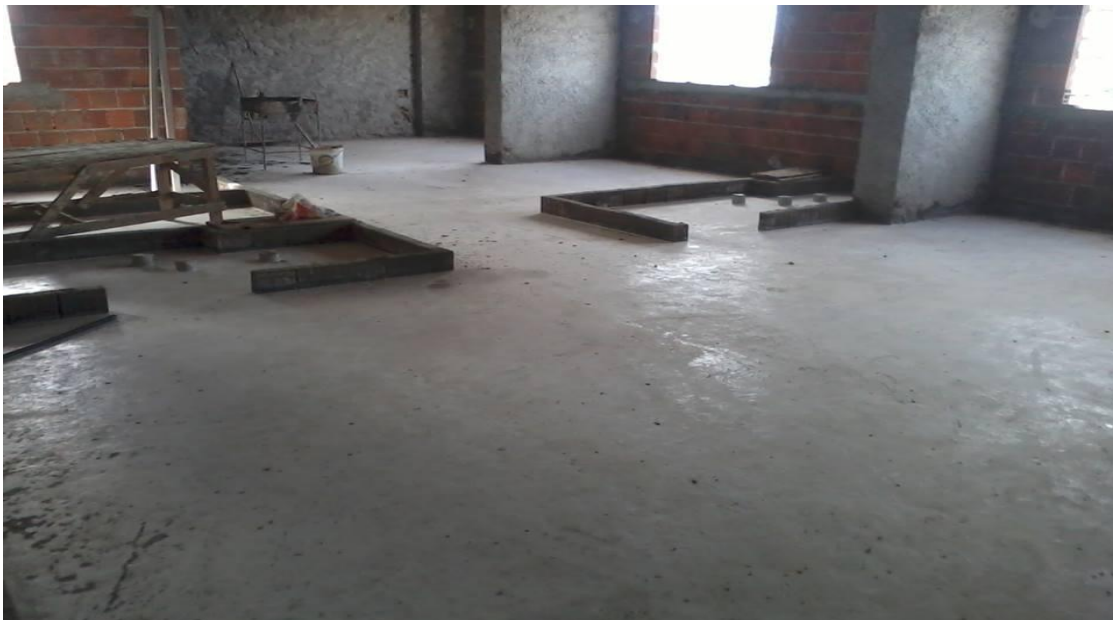
Figura 2 –Etapa concluída do contrapiso autonivelante.
