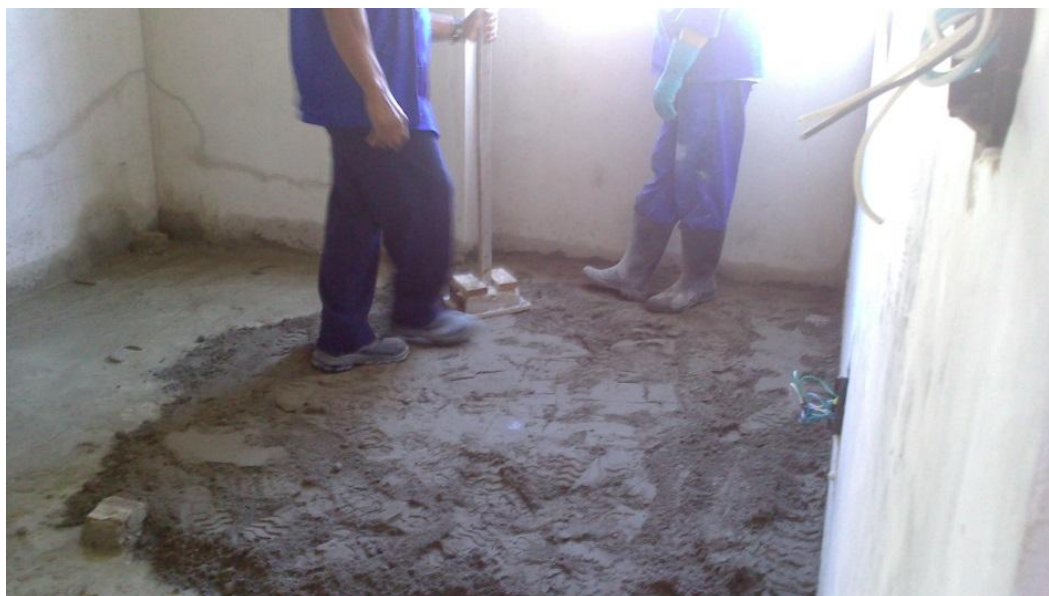
Figura 1 – Execução do contrapiso Tradicional.
