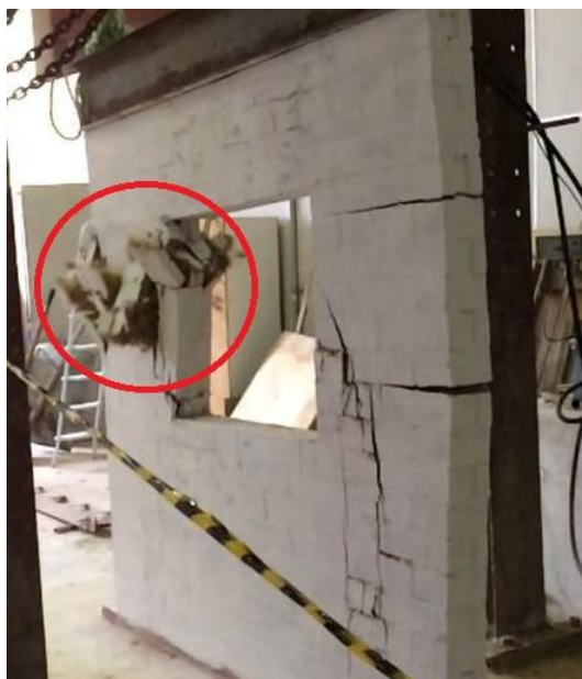
Figura 38. Ruptura da Parede 2.
