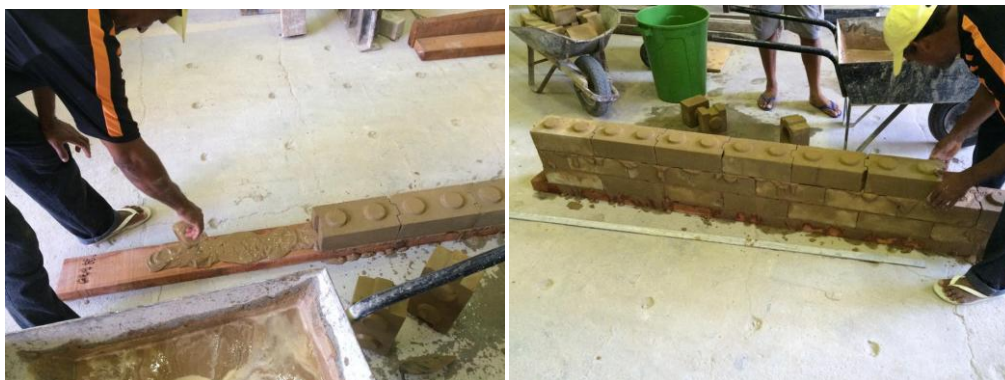
Figura 27. Construção das primeiras fiadas do painel.
