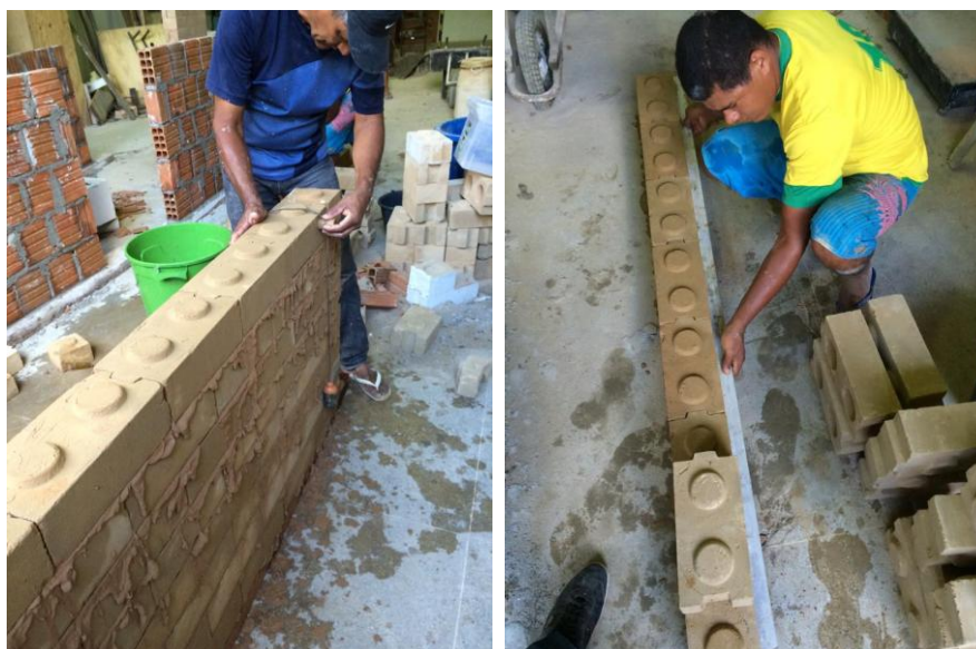
Figura 28. Prumo e retilinidade sendo verificados, respectivamente.
