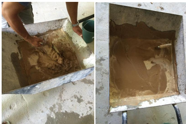
Figura 25. Produção da argamassa de terra.
