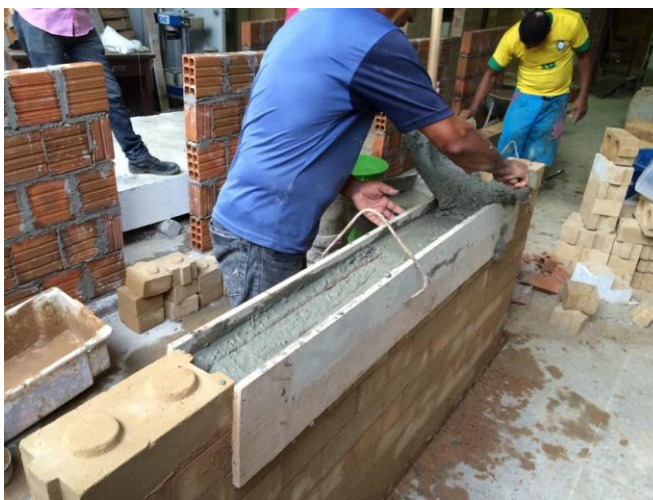
Figura 29. Concretagem da contraverga.
