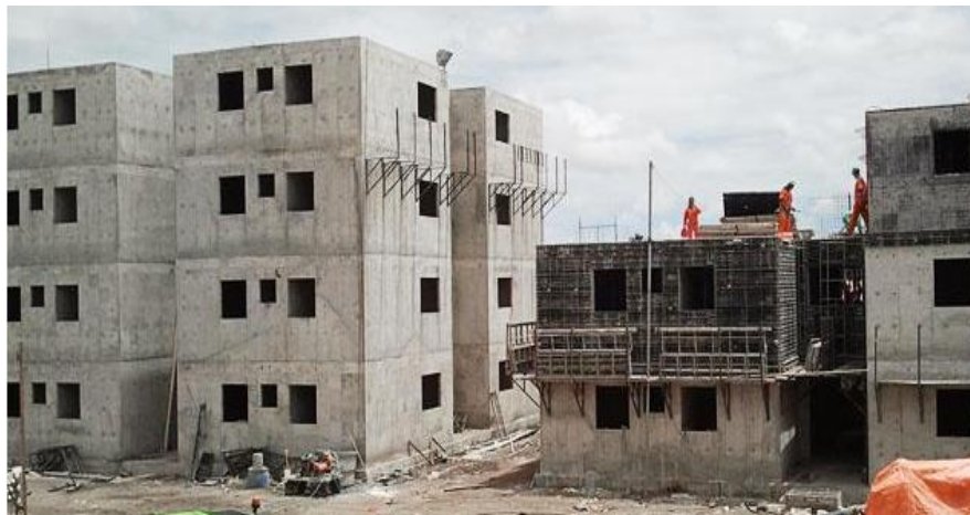
Figura 8 – Acabamento das paredes de concreto após a desforma
