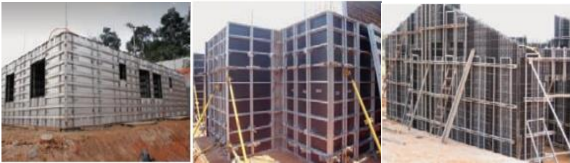
Figura 9 – Tipos de fôrmas: metálicas, metálicas + compensado e plásticas
