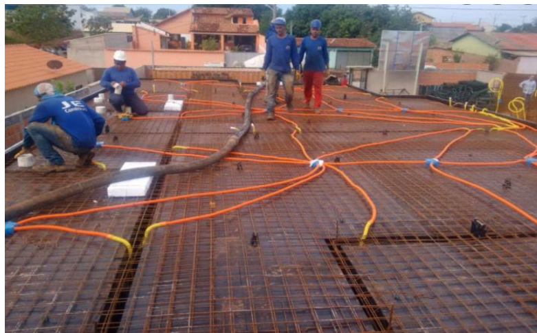
Figura 14 – Fixação das instalações na laje
