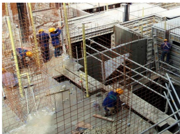
Figura 11 – Fixação da armadura principal
