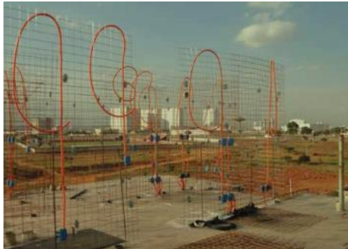
Figura 12 – Fixação dos eletrodutos e caixas elétricas
