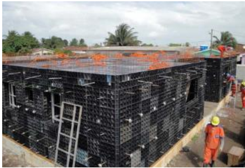
Figura 13 – Execução das fôrmas
