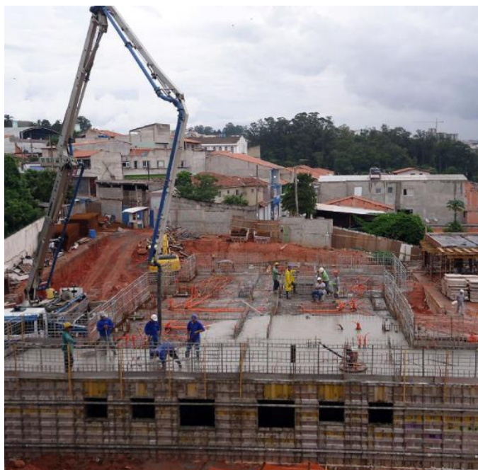
Figura 16 – Concretagem das lajes dos ambientes com paredes já executadas
