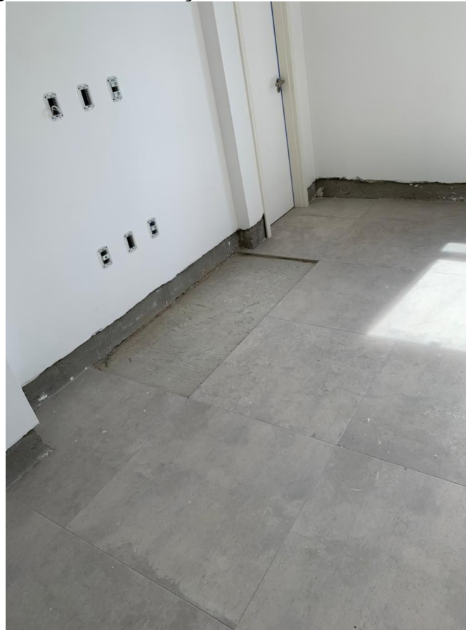
Figura 09: Substituição de revestimento danificado
