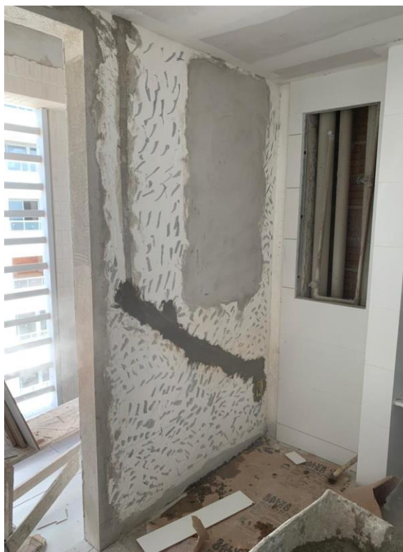
Figura 07. Chumbamentos de eletrodutos de caixas elétricas
