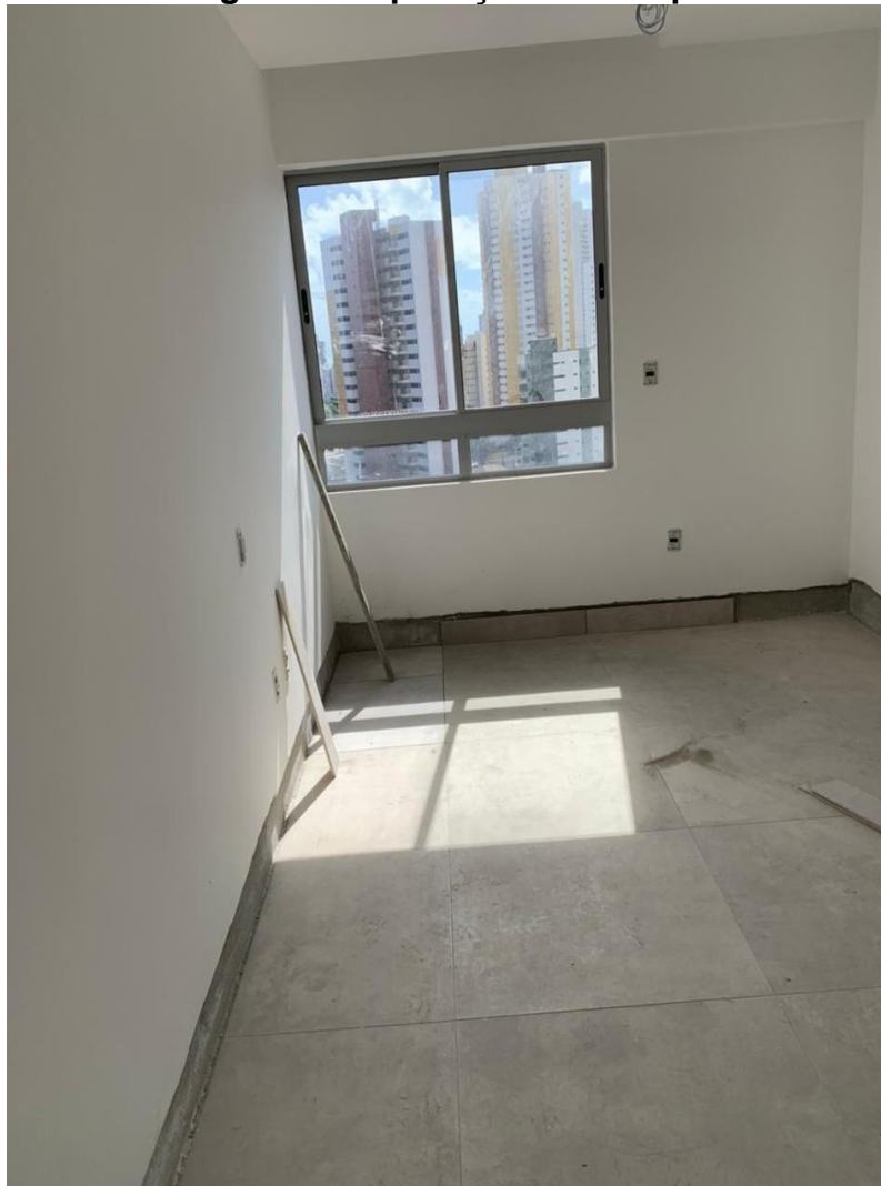
Figura 08. Aplicação de rodapé
