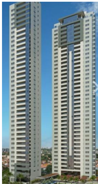
Figura 02. Imagem frontal da edificação
