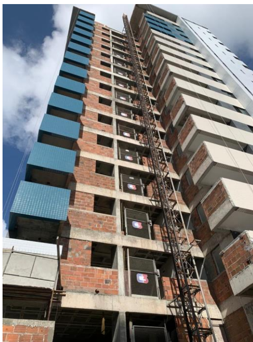
Figura 6 - Obra em estudo
