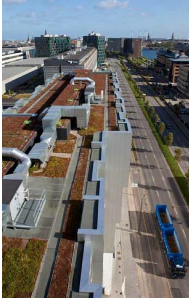
Figura 34 - Telhados verdes no bairro de Kalvebod Brygge, em Copenhague. Fonte: (GAETE, 2014).
