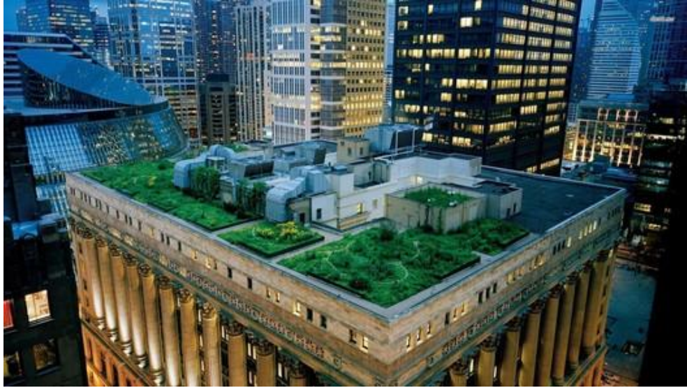
Figura 10 - Exemplo de cobertura verde. Fonte: (CALDAS, 2020).
