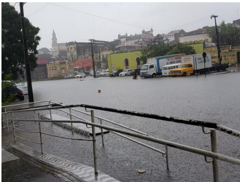
Figura 42 - Alagamento na Av. Sanhauá, no Bairro do Varadouro, em 2019.
