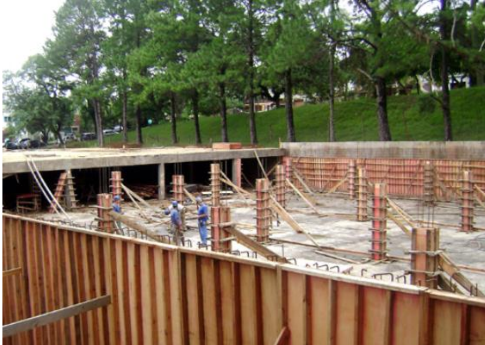
Figura 35 - Construção de reservatório de detenção na Praça Celso Luft, Porto Alegre. Fonte: (PROGRAMA SOLUÇÕES PARA CIDADES, 2013).
