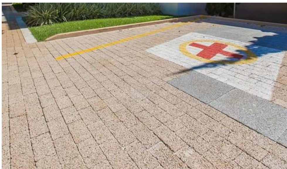
Figura 13 - Exemplo de pavimento de concreto intertravado drenante. Fonte: (CALDAS, 2020).
