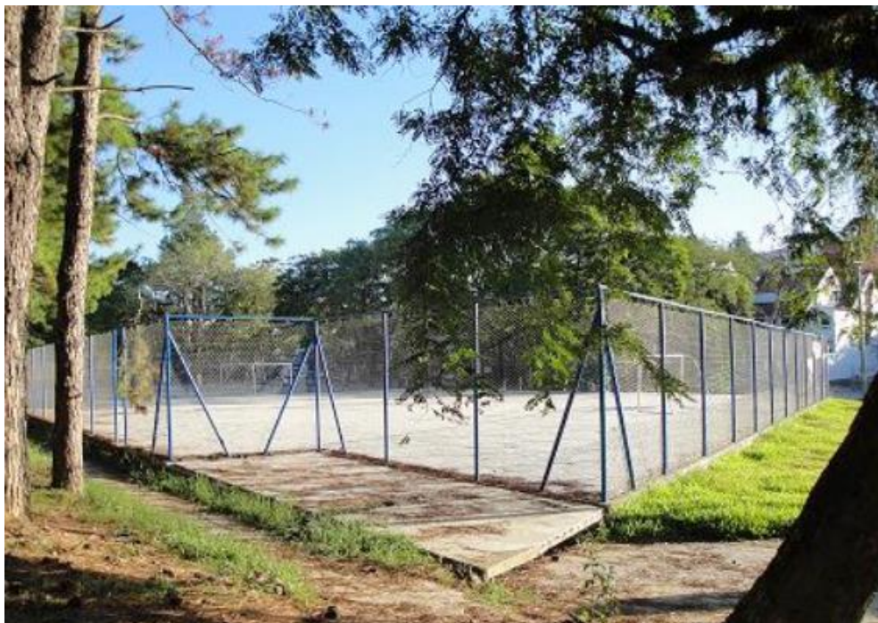
Figura 36 - Quadra de esporte sob a qual está construído o reservatório. Fonte: (PROGRAMA SOLUÇÕES PARA CIDADES, 2013).
