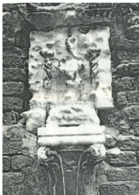
Figura 20 – Desagregação em material lapidado
