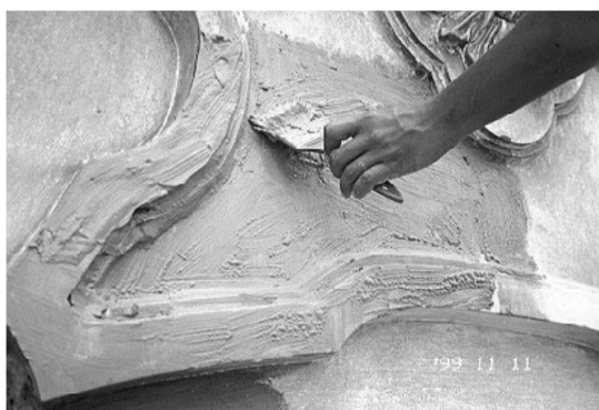
Figura 30 – Limpeza de Cantaria, lama bentonitica
