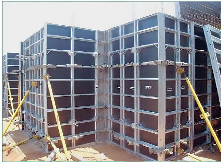
Figura 4 – Forma metálica + compensado para execução de parede de concreto.
