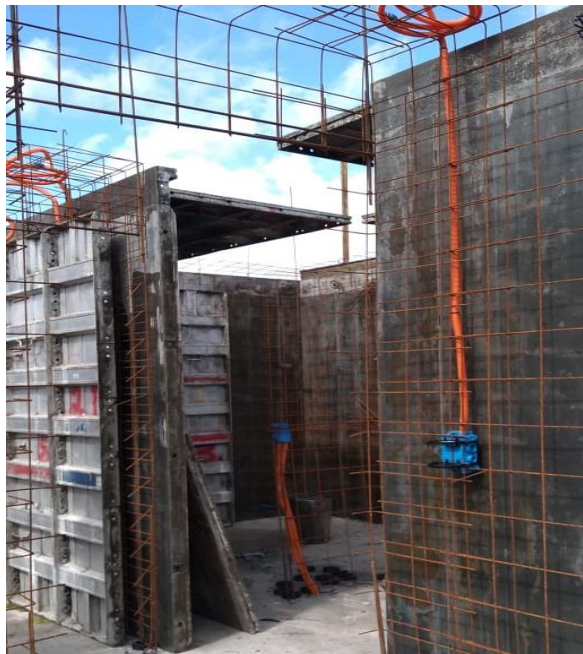
Figura 2 – Armações no interior das formas em execução de alvenarias estruturais moldadas in loco.
