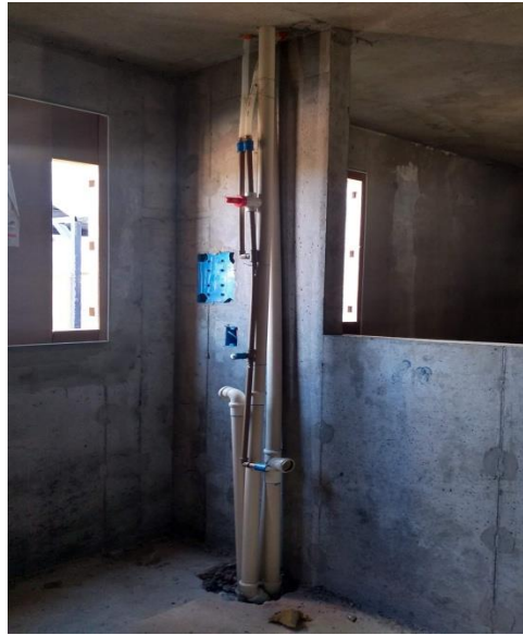
Figura 6 – Instalação hidráulica em shaft.
