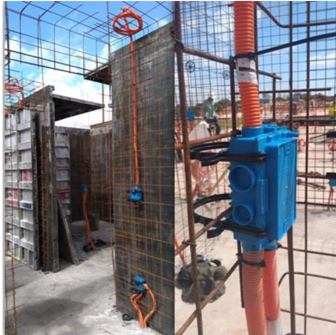
Figura 7 – Fixação das instalações elétricas na tela de armação.
