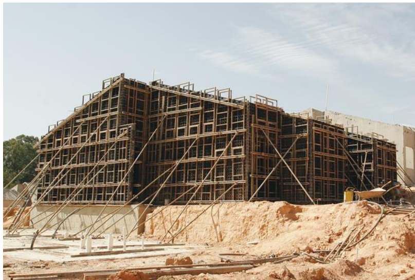
Figura 5 – Forma plástica para execução de parede de concreto.
