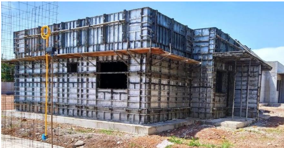
Figura 3 – Forma metálica para execução de parede de concreto.
