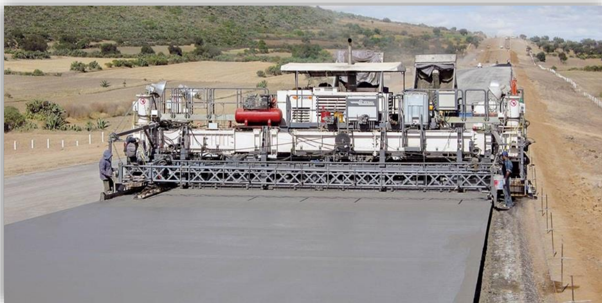
Figura 52. Execução do pavimento rígido. Fonte: http://asfaltodequalidade.blogspot.com .
