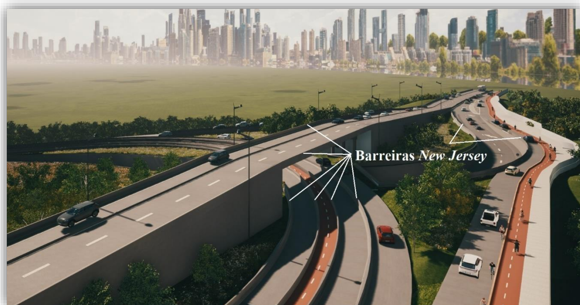
Figura 87. Barreiras New Jersey.
