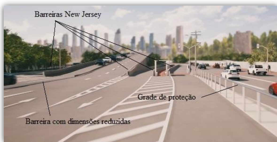
Figura 85. Elementos de segregação de faixas de rolamento.
