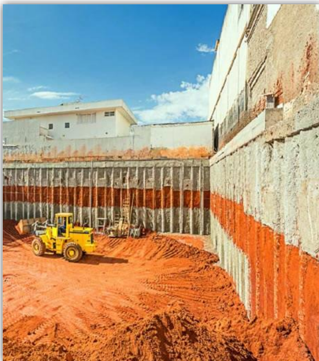
Figura 58. Obra com estacas justapostas. Fonte: ENGESOL.
