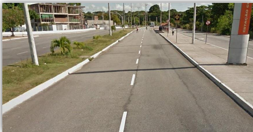
Figura 71. Vista geral do pavimento. Fonte Google Earth.
