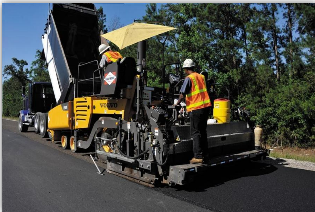
Figura 53. Execução do pavimento flexível. Fonte: https://www.constructionequipmentguide.com .
