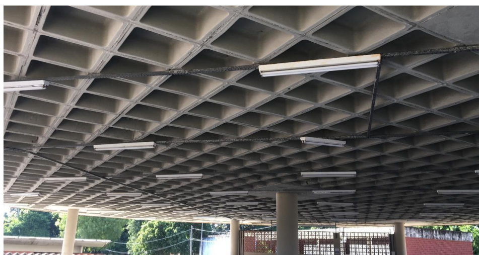
Figura 8 - Exemplo de edificação executada com laje nervurada de cubetas
