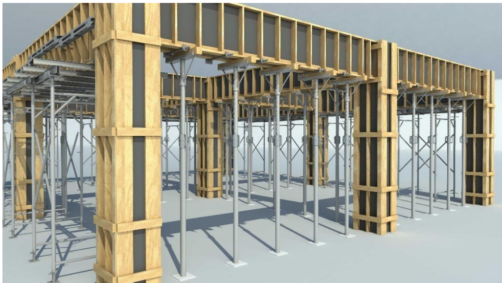
Figura 2 – Ilustração de fôrmas de madeira e escoramento metálicos em laje maciça
