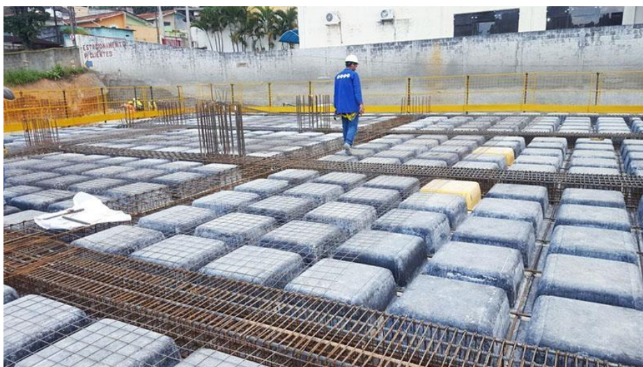
Figura 7 - Exemplo de montagem de laje nervurada com cubetas plásticas
