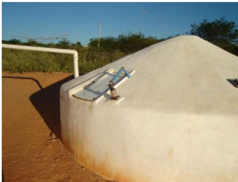
Figura 5: Cisterna de placas de cimento concluída
