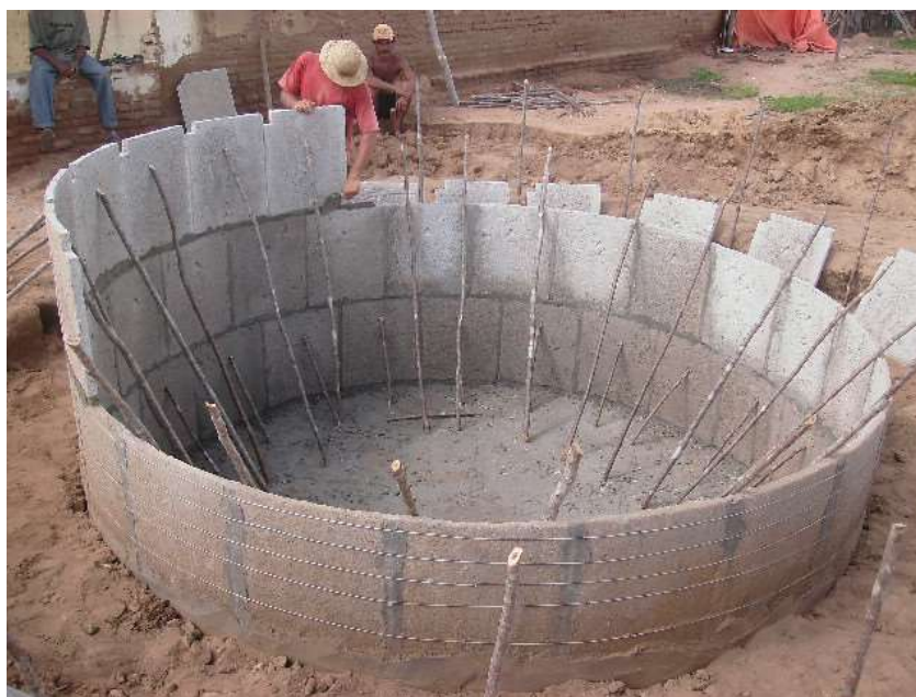
Figura 4: Construção de uma cisterna de placas de cimento
