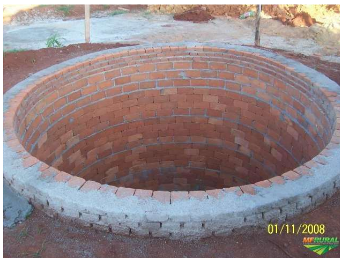
Figura 6: Cisterna de tijolos sem o telhado e em fase de acabamento
