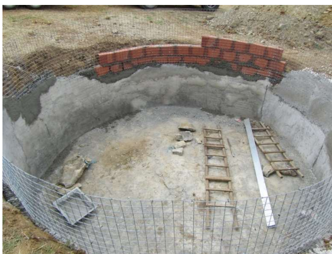
Figura 6: Cisterna de tijolos em fase de construção
