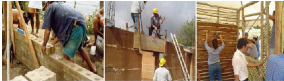
Figura 5 - Métodos construtivos com terra. a) blocos de terra comprimidos; b) parede monolítica; c) técnica mista.
