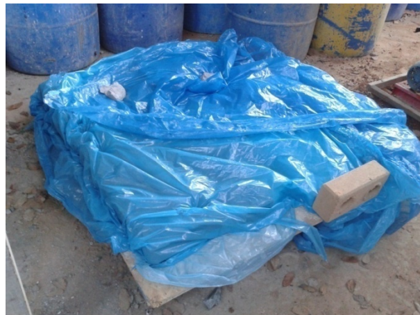
Figura 15 - Blocos envolvidos por lona plástica.
