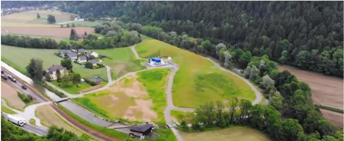
Figura 36 - Projeto de remediação finalizado
