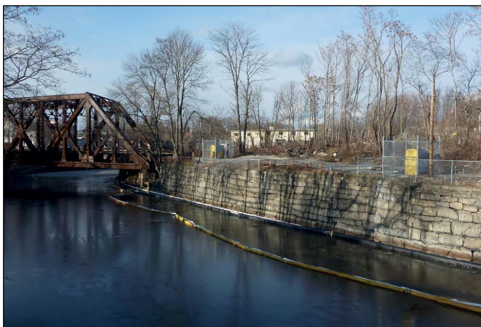
Figura 27 - Cortina de absorção de óleo na água feita com geocomposto de carvão ativado
