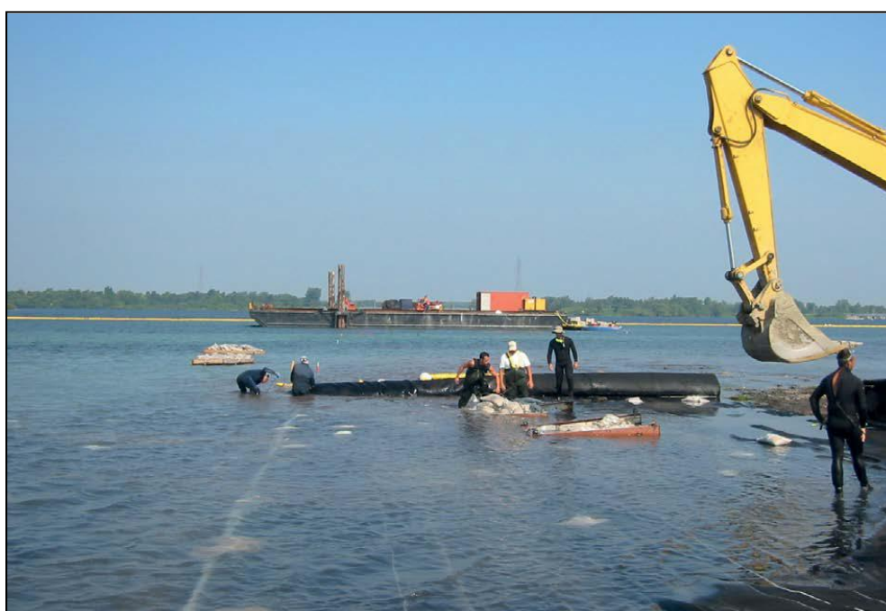
Figura 29 - Encapsulamento em leitos de corpos d'água
