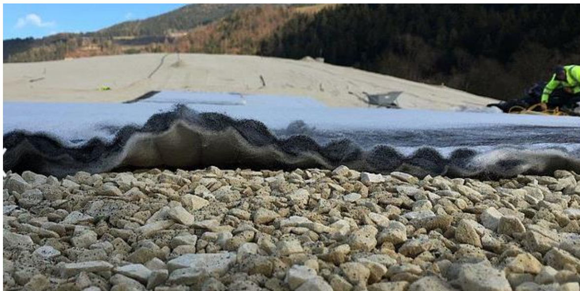
Figura 33 - Tektoseal Active AC aplicado no local contaminado
