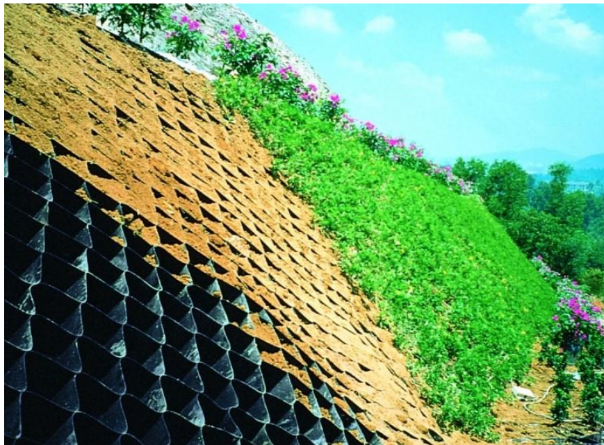
Figura 10 - Geocélula aplicada em talude
