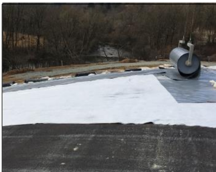
Figura 34 - Instalação do sistema de cobertura
