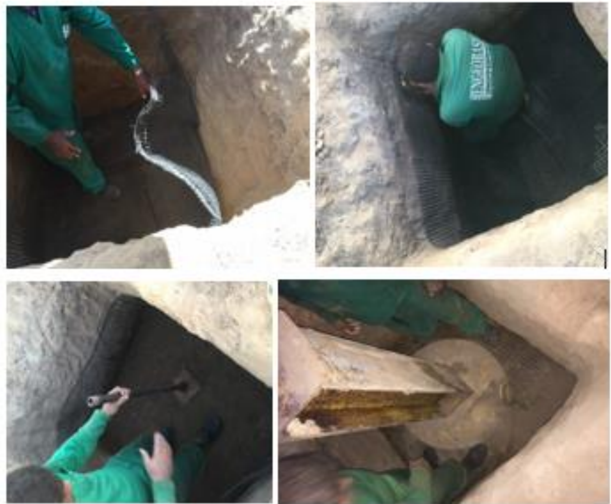
Figura 19 – Envelopamento do solo e montagem da estrutura de ensaio
