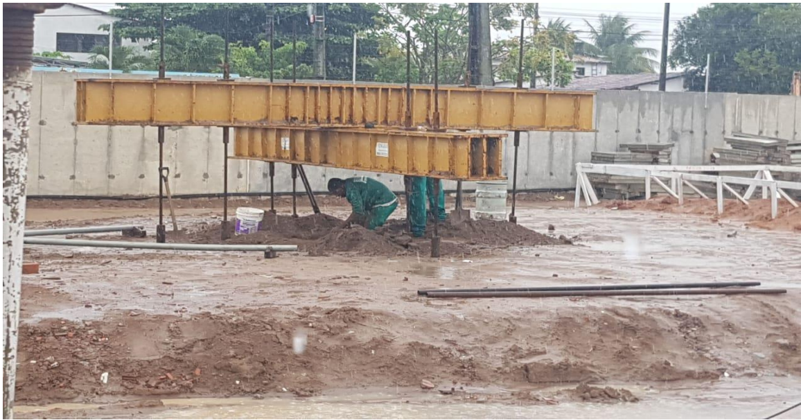
Figura 14 - Montagem das vigas de reação
