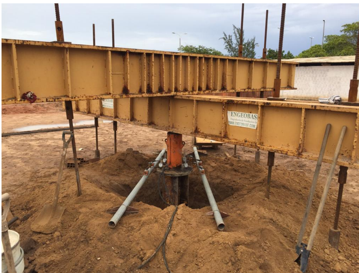
Figura 18 – Estrutura de ensaio montada
