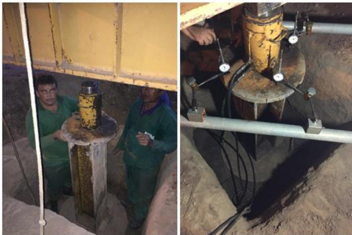
Figura 20 – Ensaio de prova de carga para o solo reforçado
