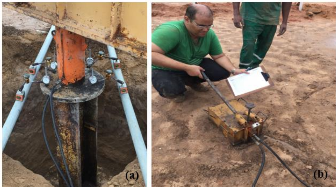
Figura 17 – (a) relógios extensômetros (b) bomba (auxilia na aplicação da carga)
