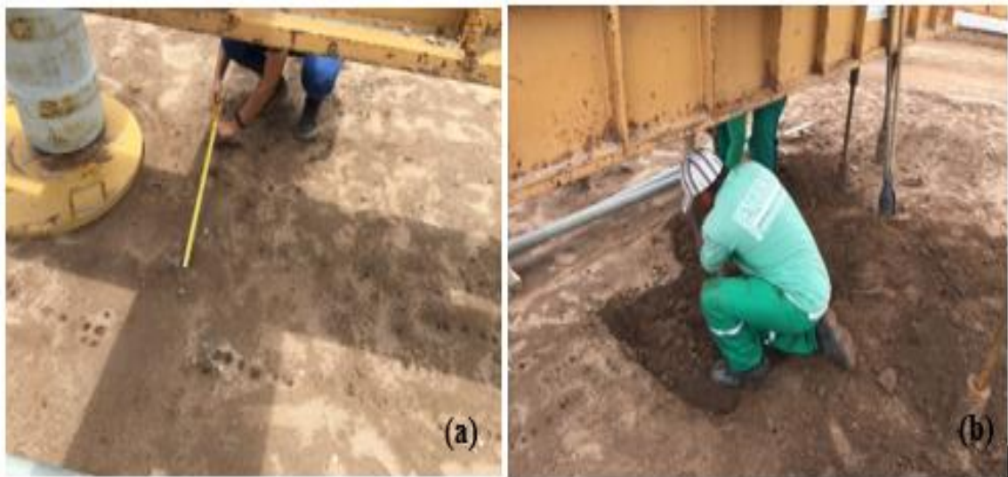
Figura 15 – (a)medições das dimensões (b)processo de escavação
