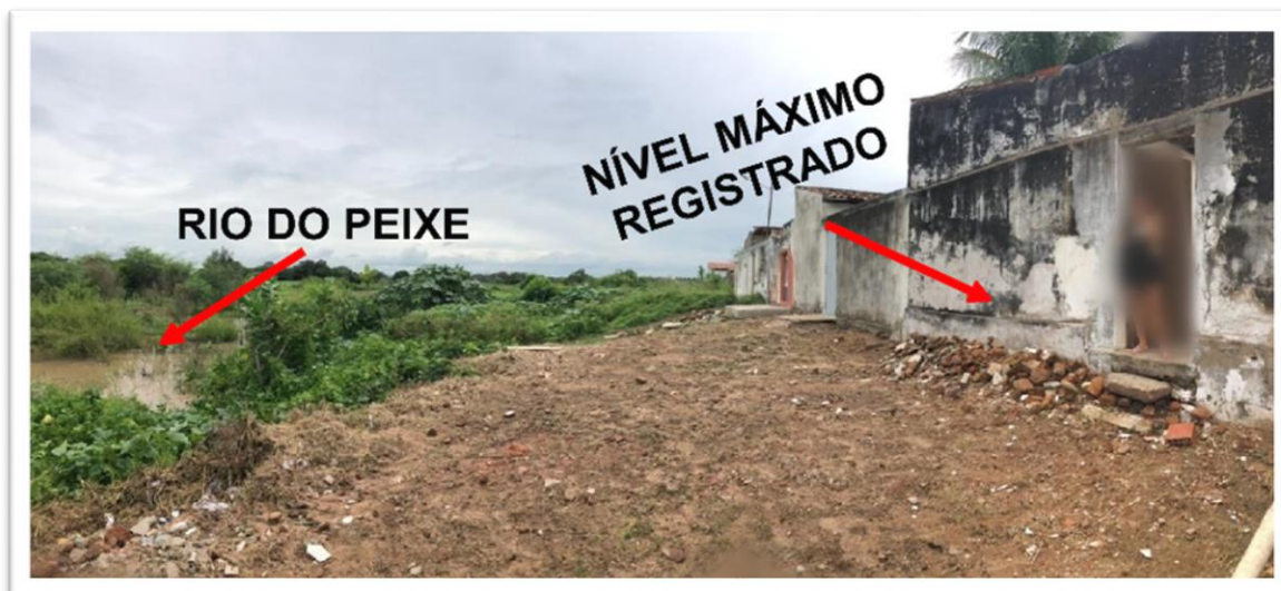
Figura 17 – Localização do ponto de referência para a definição da escala de risco a inundações
