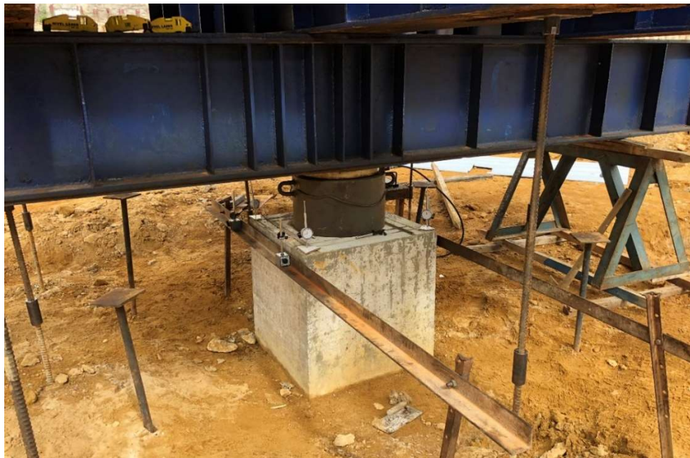
Figura 12: Macaco hidráulico e bloco de coroamento.
