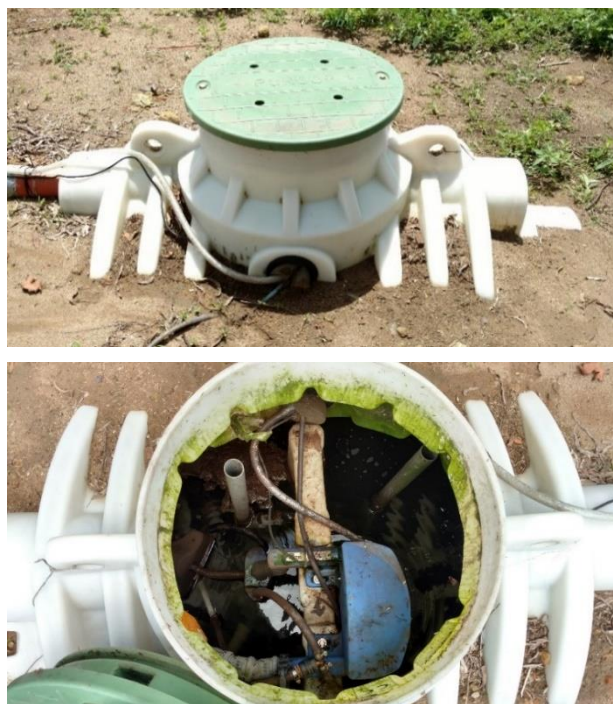
Figura 7 - Reator de Bateladas Sequencial na Instalação Experimental do BRAMAR.
