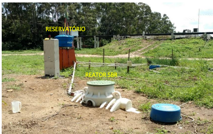
Figura 6 - Instalação do SBR na ETE Mangabeira.
