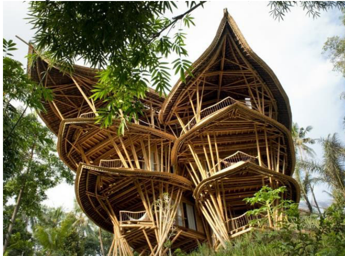
Figura 14- Casa na Indonésia construída com Bambu.
