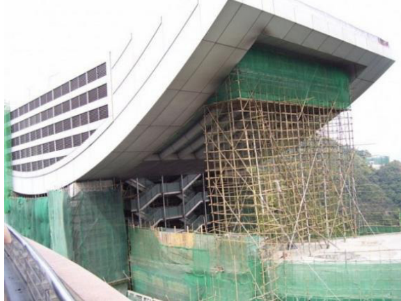
Figura 13 - Escoramento de Bambu.
