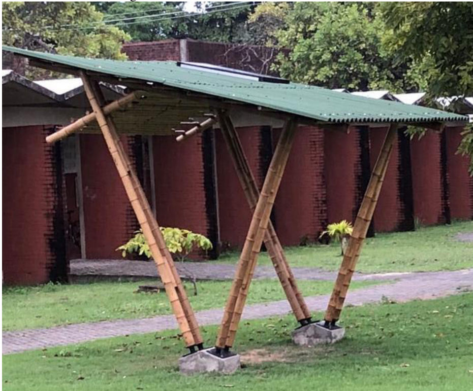
Figura 36 - Gazebo de bambu - Vista lateral.
