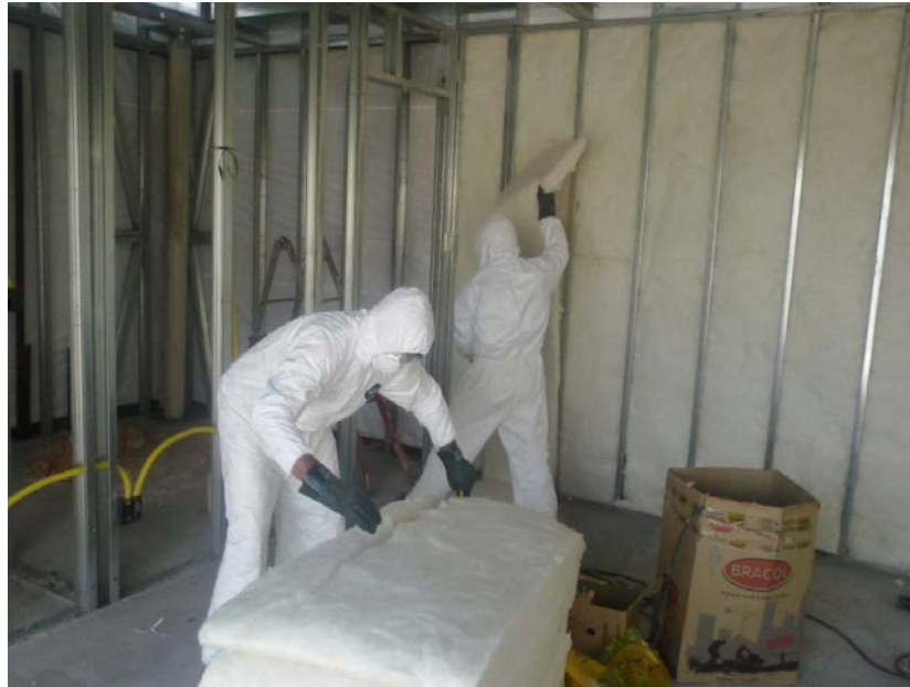
Figura 37 - Aplicação de lã de vidro
