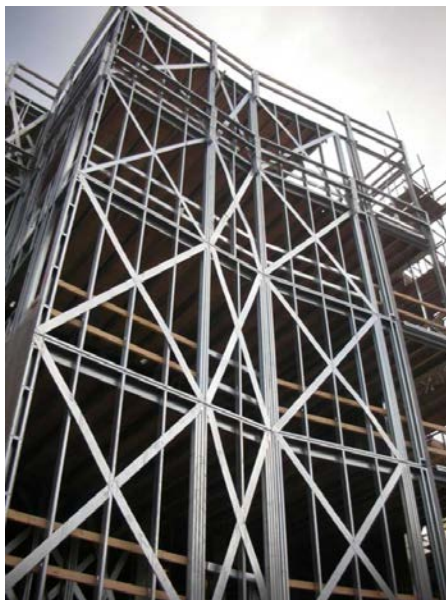
Figura 19 - Prédio em LSF com contraventamento em “X”
