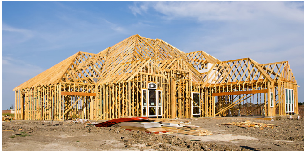
Figura 3 - Construção em Wood Frame
