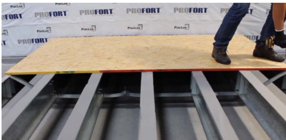
Figura 24 - Fixação de placa oriented strand board no painel horizontal
