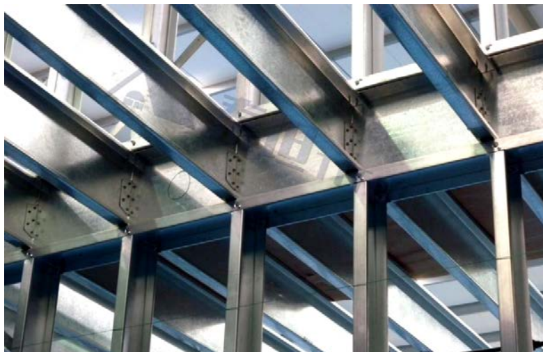
Figura 22 - Ligação executada de painéis horizontais e verticais
