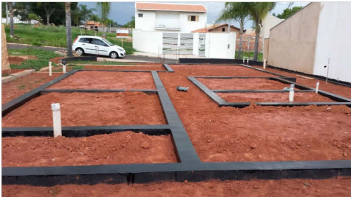
Figura 8 - Vigas de fundação
