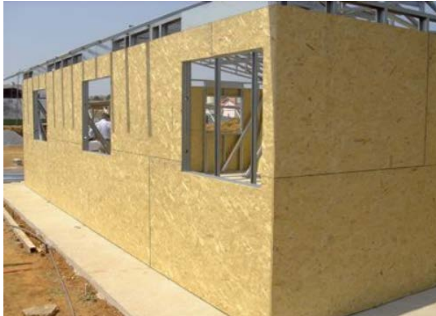
Figura 31 - Fechamento com placas OSB
