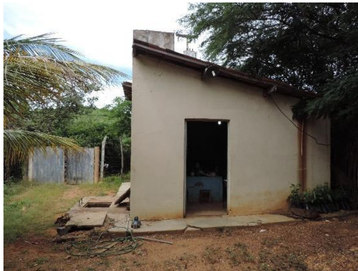
Figura 9 – EEAB do SAA do município de Manaíra
