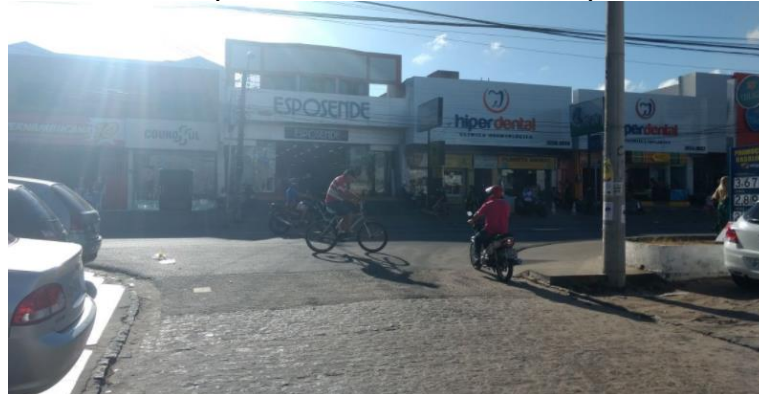
Figura 22: Ausência de placa de PARE no cruzamento da quadra B do trecho 02
