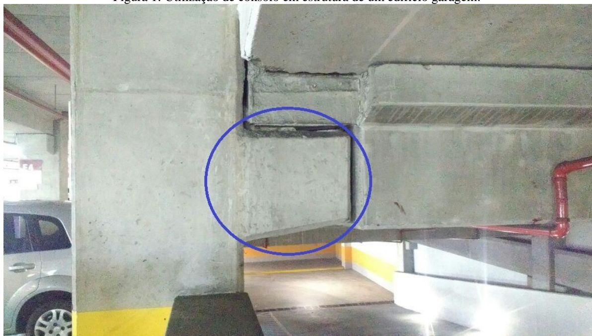
Figura 1: Utilização de consolo em estrutura de um edifício garagem.
