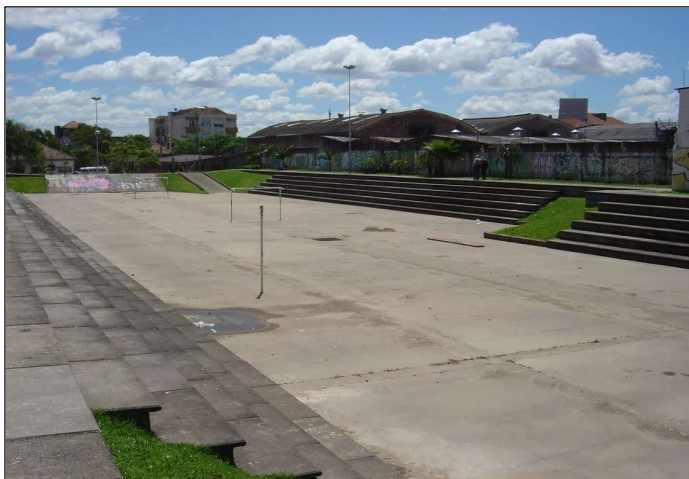
Figura 17 - Reservatório de retenção - Praça Júlio Andreatta
