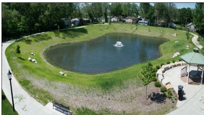
Figura 13 - Reservatório de retenção na Second Street na cidade de Champaign, Illinois.
