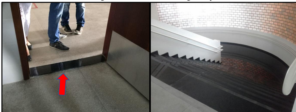
Figura 30: Soleira e escada em granito polido
