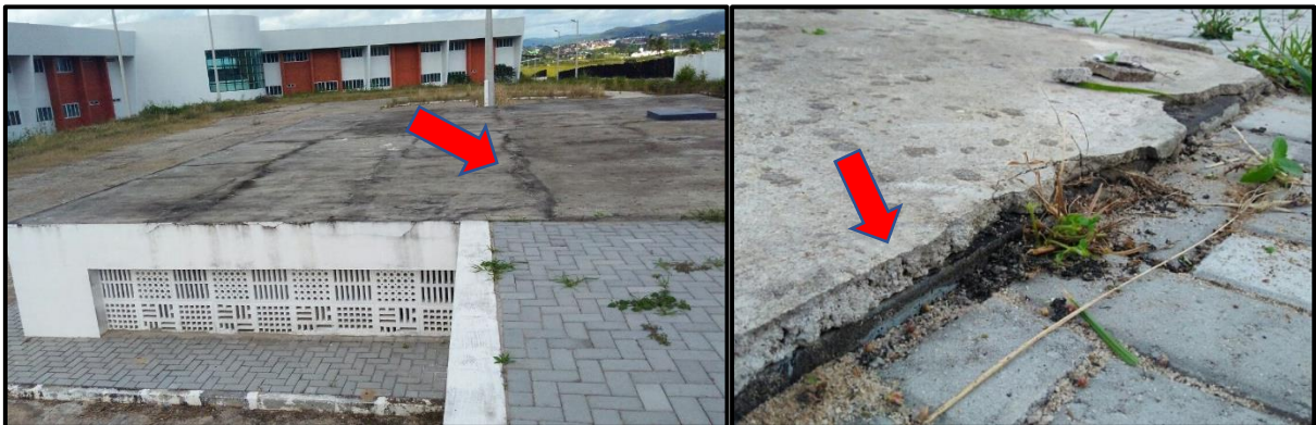
Figura 24: Impermeabilização do reservatório
