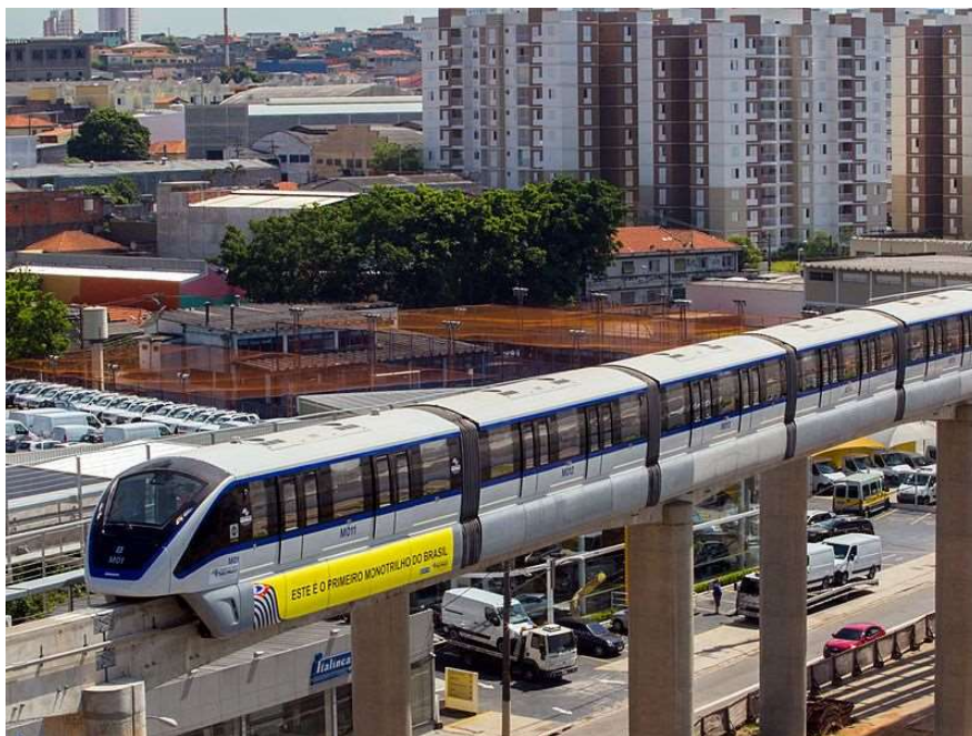
Figura 1 – Exemplo de Carga Móvel em Estruturas: Monotrilho
