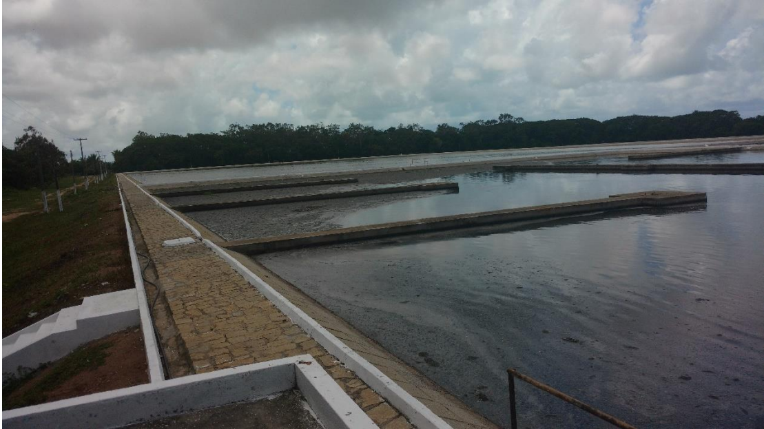
Figura 13 - Vista geral da ETE Mangabeira
