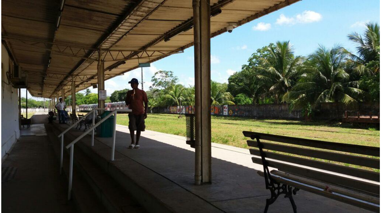
Figura 12 – Estação João Pessoa
