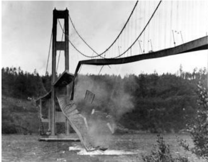
Figura 5 – Ponte Tacoma Narrows após a ruptura devido à ressonância.
