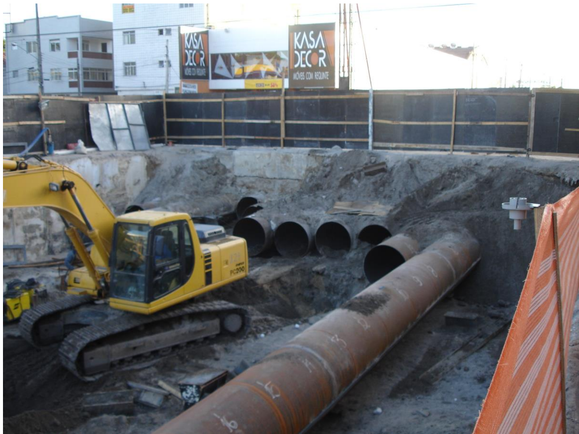
Figura 26 – Cravação dos tubos do túnel sob Av. Herculano Bandeira
