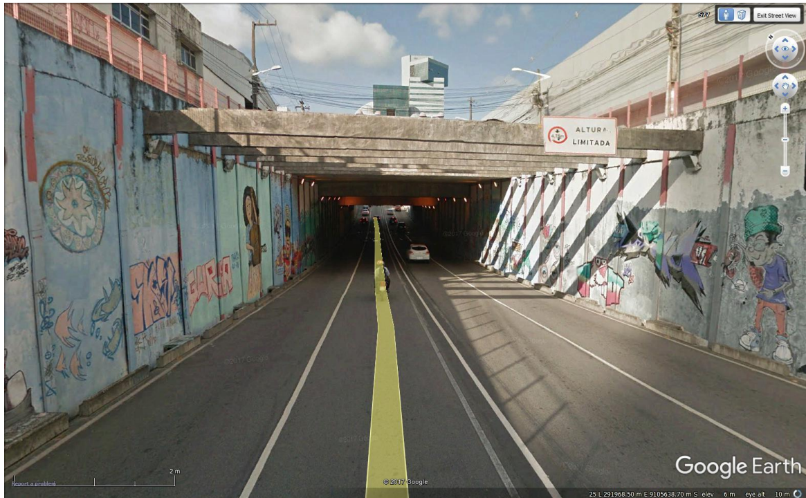
Figura 27 – Fotografia da entrada do túnel sob a Av. Herculano Bandeira
