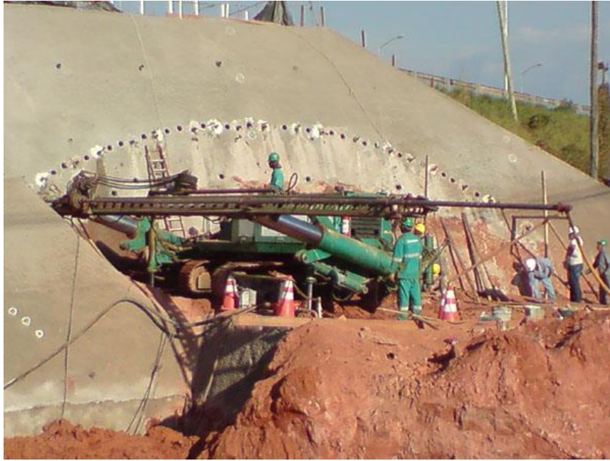
Figura 20 – Perfuratriz realizando furos para a enfilagem
