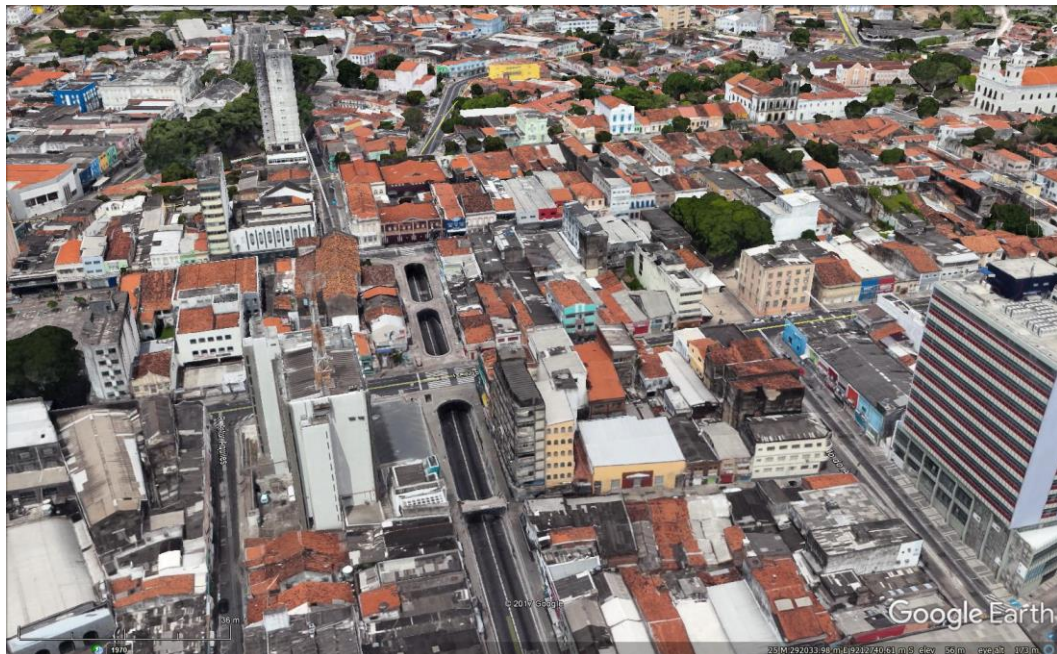
Figura 32 – Túnel da Av. Miguel Couto
