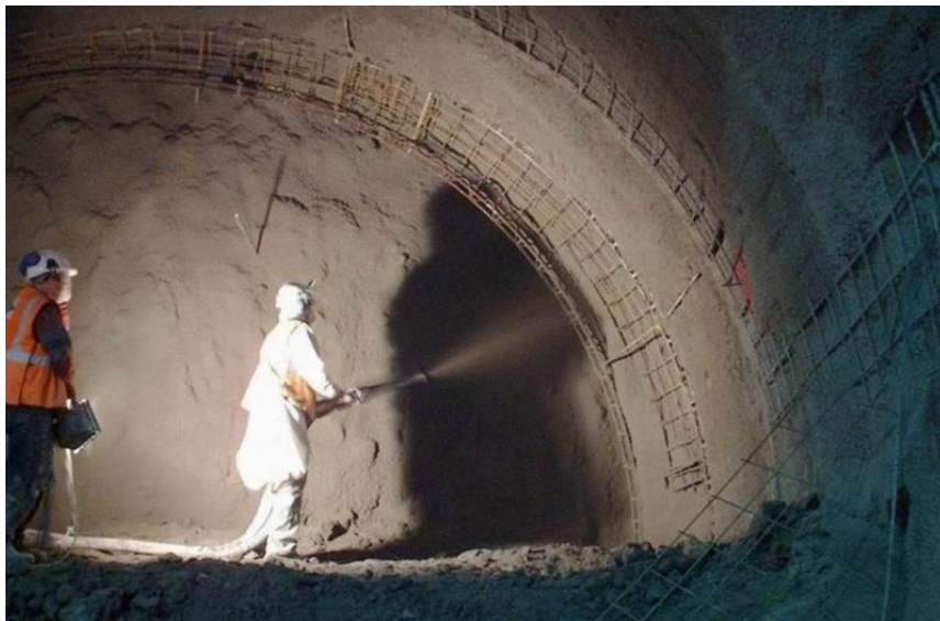
Figura 23 – Concreto projetado aplicado em parede de túnel NATM
