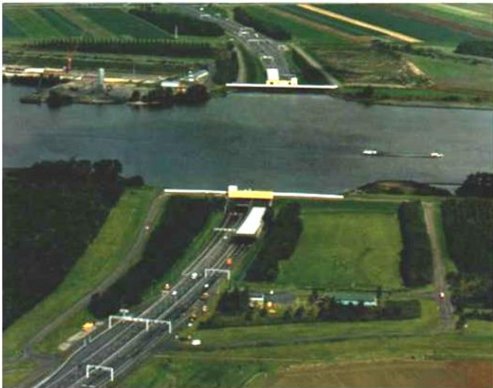
Figura 9 – Túnel Heinenoord, Holanda
