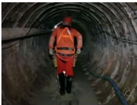
Figura 5 – Imagem das obras no túnel da lagoa
