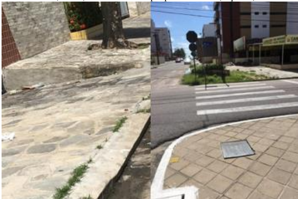
Figura 10 - Desníveis (Direita) e ausência de rampas para deficientes (esquerda) no Bairro Manaíra
