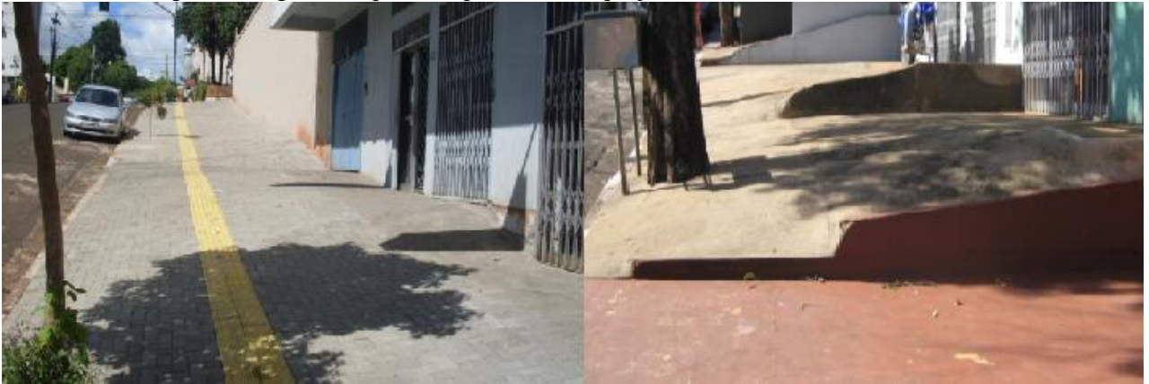
Figura 6 - Figura a esquerda depois do readequação e a direita retratando antes
