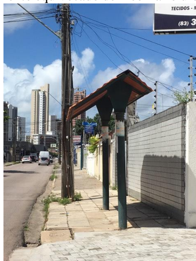
Figura 13 - Posicionamento equivocado de mobiliário urbano no Bairro Manaíra
