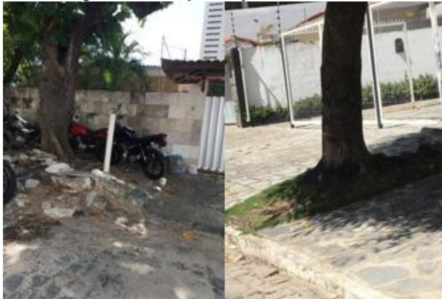
Figura 14 - Arborização inadequada no Bairro Manaíra
