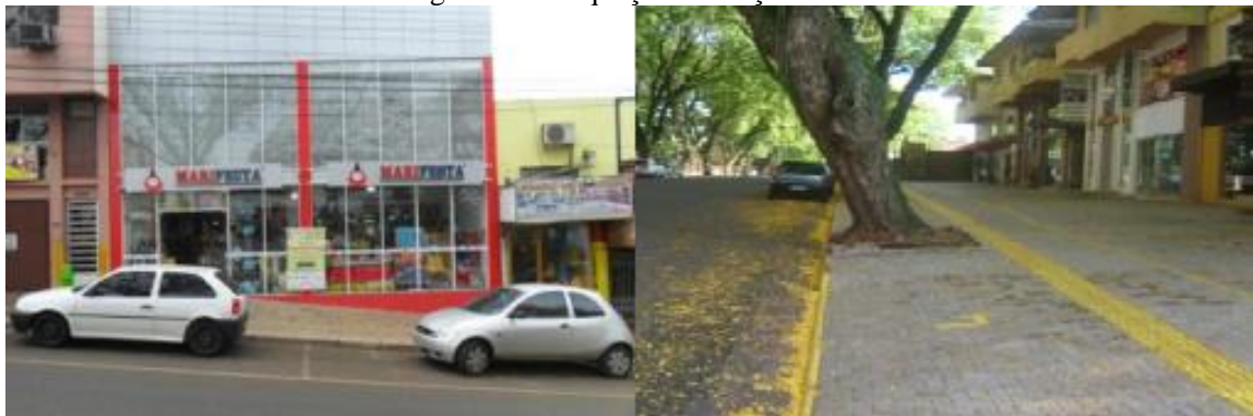
Figura 5 - Adequação do calçamento
