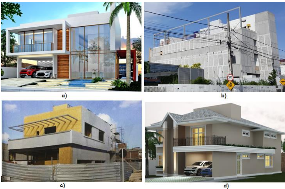
Figura 3 - Obras com Light Steel Frame na Paraíba.
