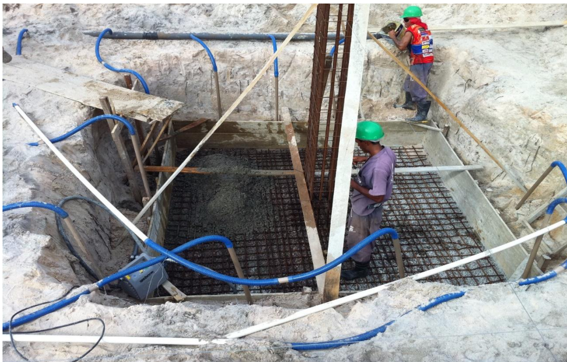
Figura 12 - Execução dos serviços com o rebaixamento implantado
