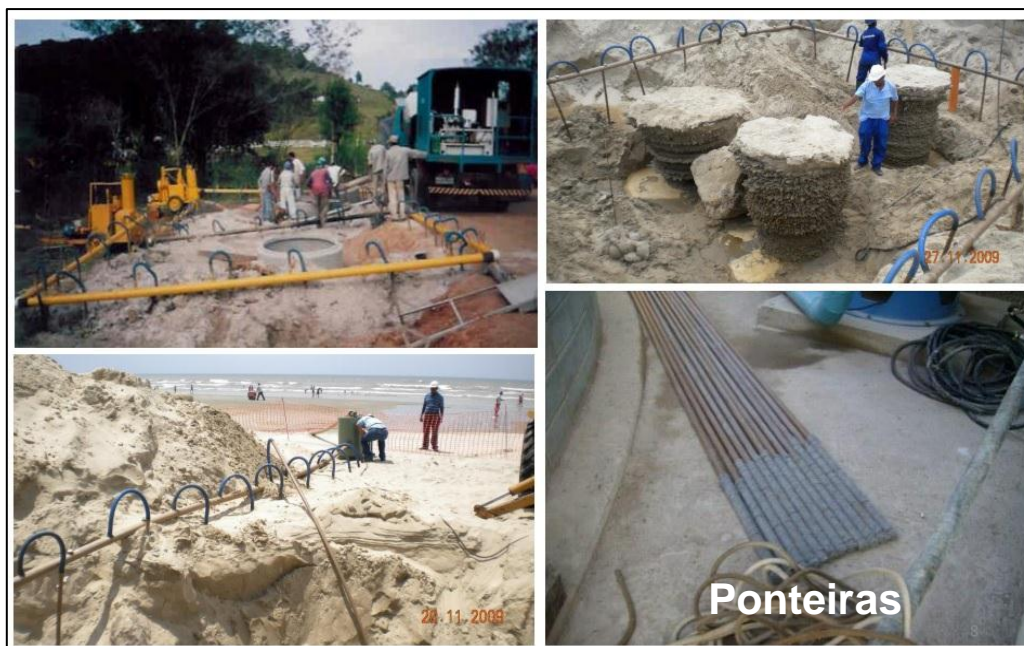
Figura 4 - Aplicação de ponteiras filtrantes
