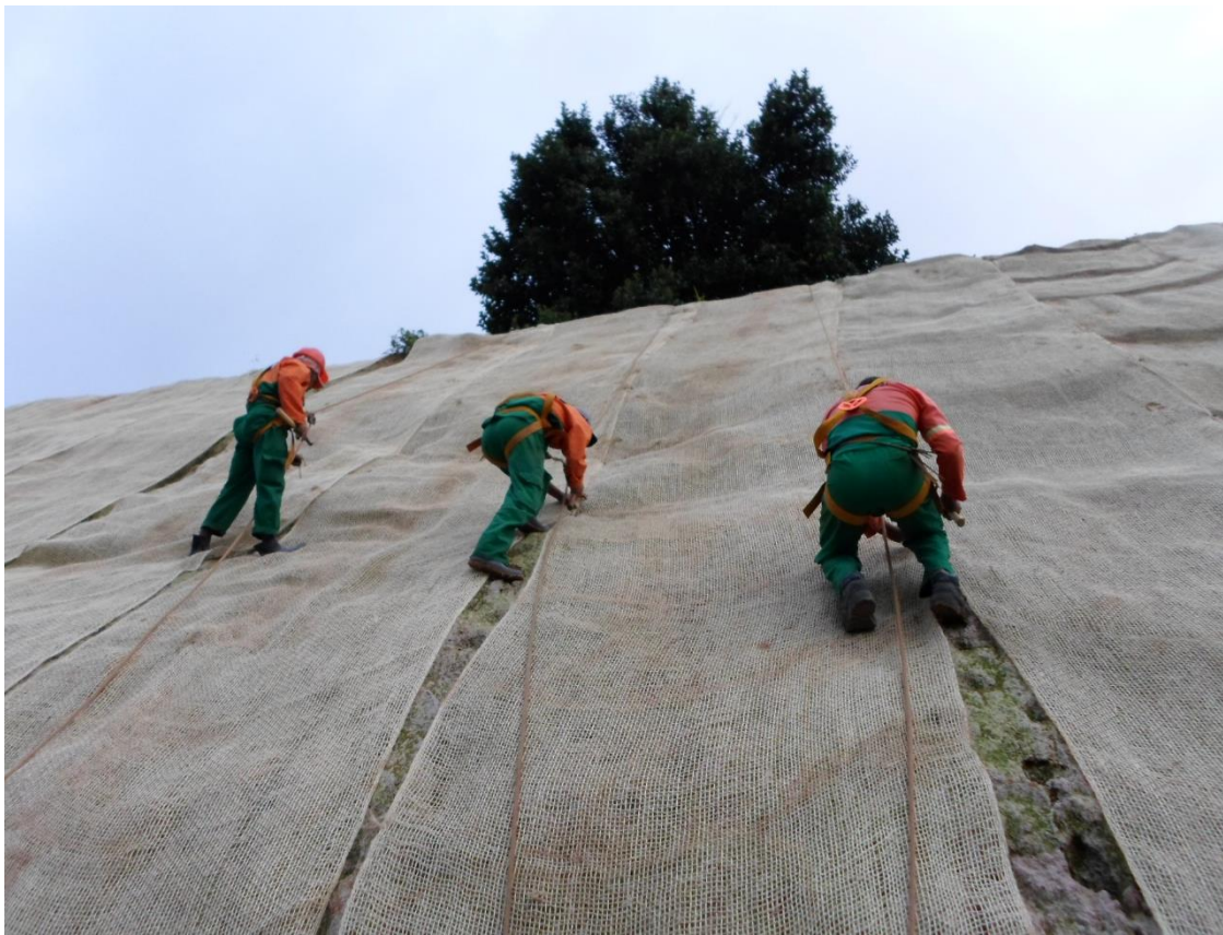
Figura 33 – Rapelistas fazem fixação de Biomanta na Comunidade do Timbó
