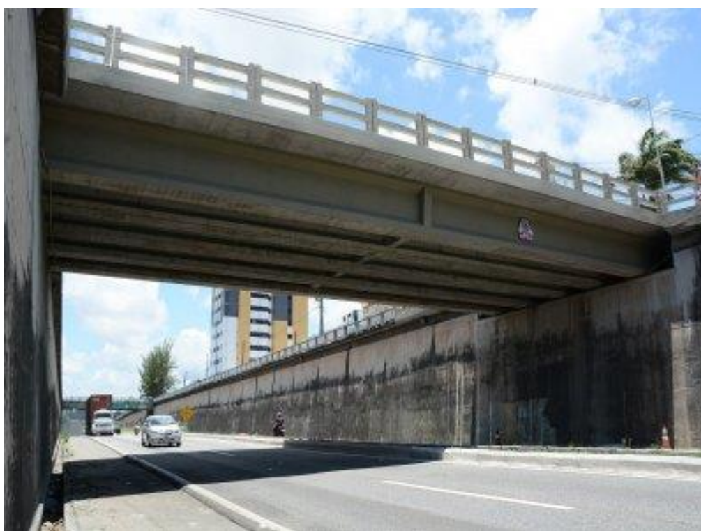
Figura 41 – Trecho da BR-230 sob o novo Viaduto Geraldo Mariz, apoiado sobre maciço de solo confinado por cortina atirantada
