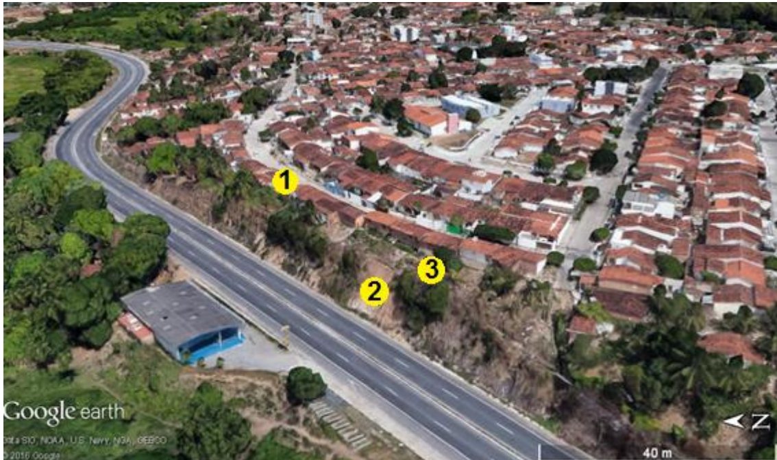
Figura 39 – Panorama do cone de contribuição sobre o talude (Google Earth Pro)
