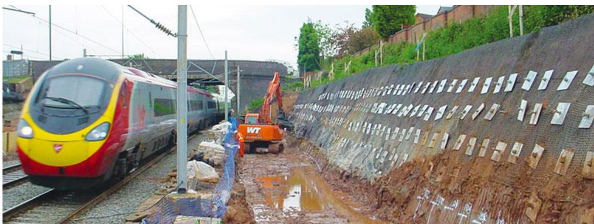
Figura 47 – Execução de Solo Grampeado de Face Verde em espaço reduzido
