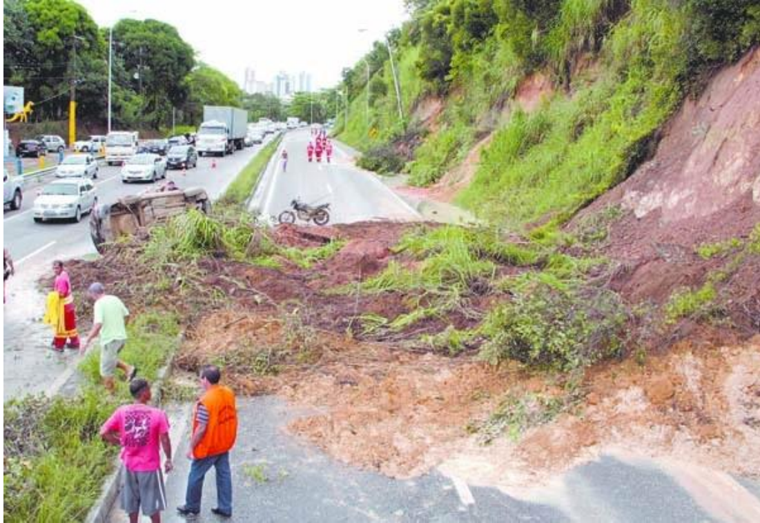
Figura 34 – Escorregamento causa acidente grave e interrupção da via no sentido João Pessoa – Cabedelo (Jun/2012)
